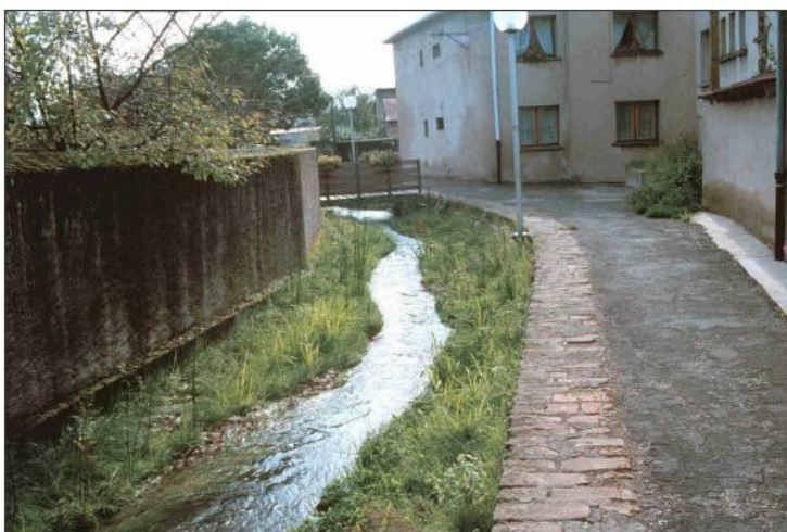
Figure 14 : Exemple de résultats de création de sinuosité dans le lit mineur par mise en place de banquettes
