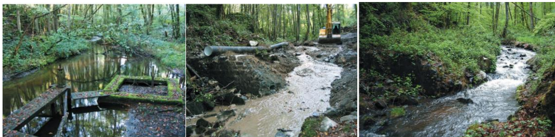
Figure 8 : Exemple de démantèlement d'un seuil - avant et après travaux (Source : OFB)
