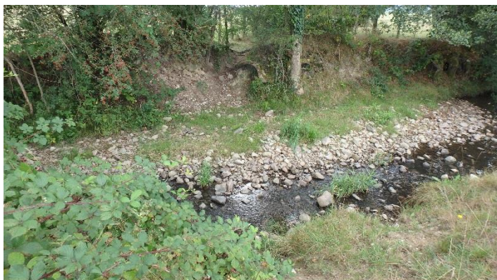
Figure 54 : Exemple de berge diversifiée suite à un effondrement
