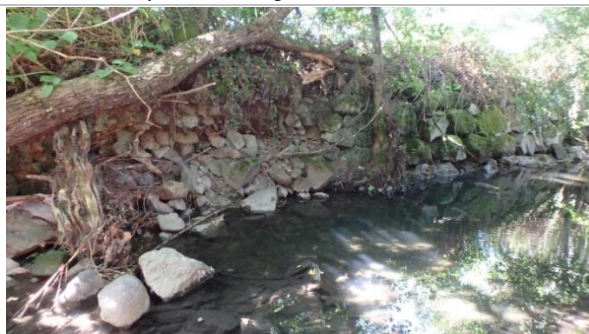
Exemple de protections de berges (mur en pierres)
