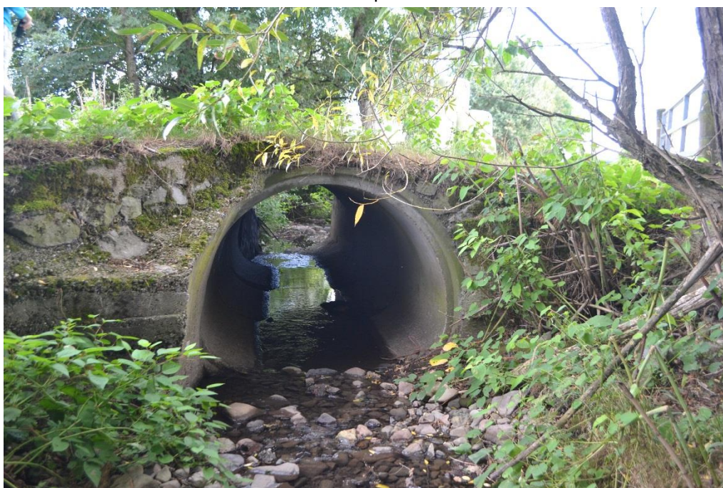
Figure 73 : Photographie de l'intérieur de la buse de la Neuve Rivière
