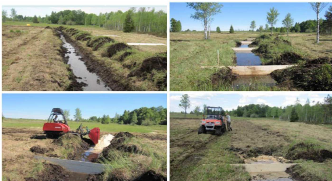
Figure 3.16 : Illustration du traitement des drains par comblement et pose de panneaux
