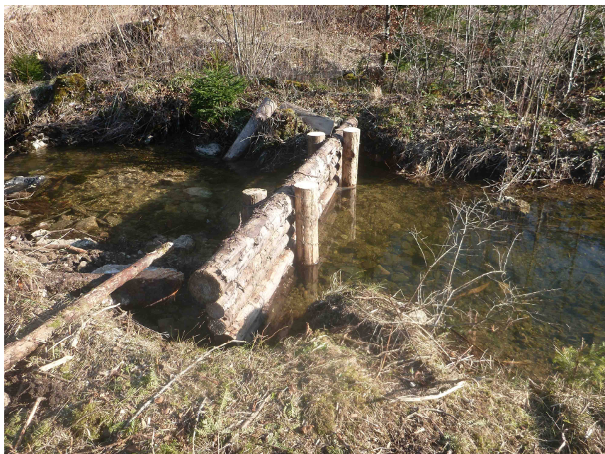
Figure 3.19 : Exemple d'un bardage rustique en construction avant le comblement d'un ancien lit
