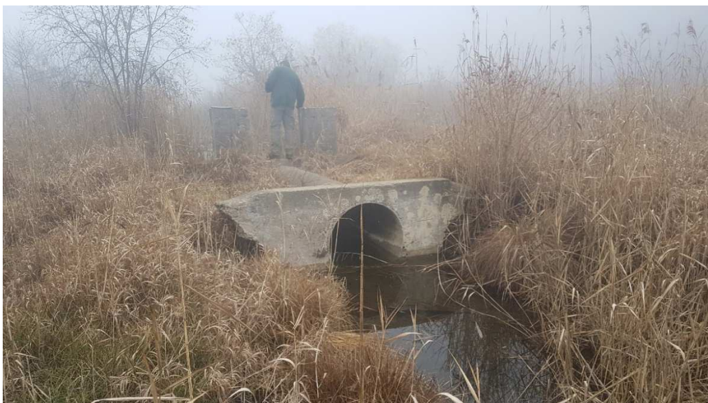
Figure 3.5 : Buse et ancien vannage à la sortie du lac datant des années 70
