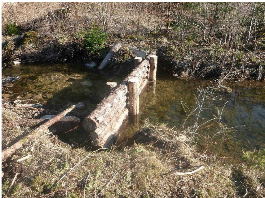
Figure 3.13 : Exemple d'un bardage rustique en construction avant le comblement de l'ancien lit
