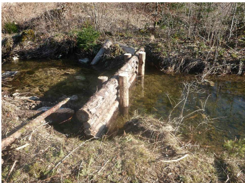
Figure 3.21 : Exemple d'un bardage rustique en construction avant le comblement de l'ancien lit
