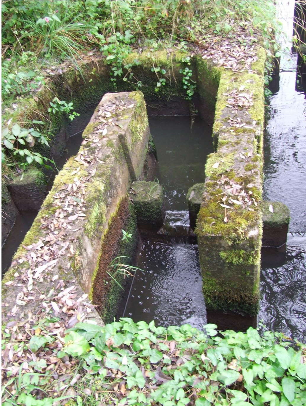
Vue de l'aller-retour des volées de la passe, entrée (aval) à droite. Débit exceptionnellement très faible, mais niveaux habituels dans la passe aisément observables.
