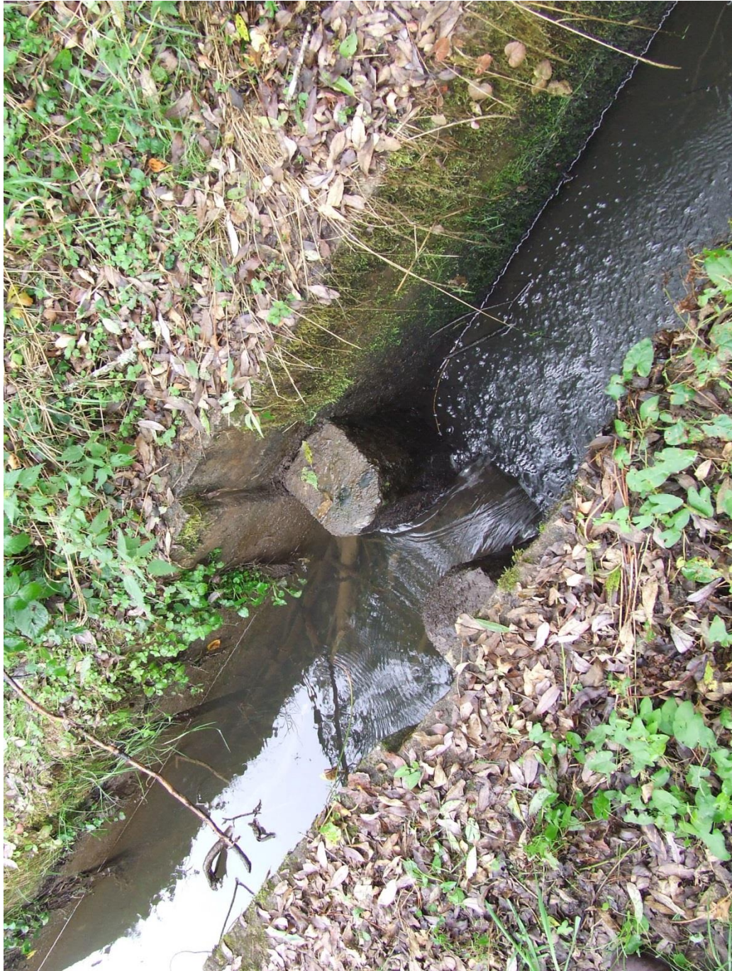
Cloison amont, dépôts et branchages au fond des bassins.
