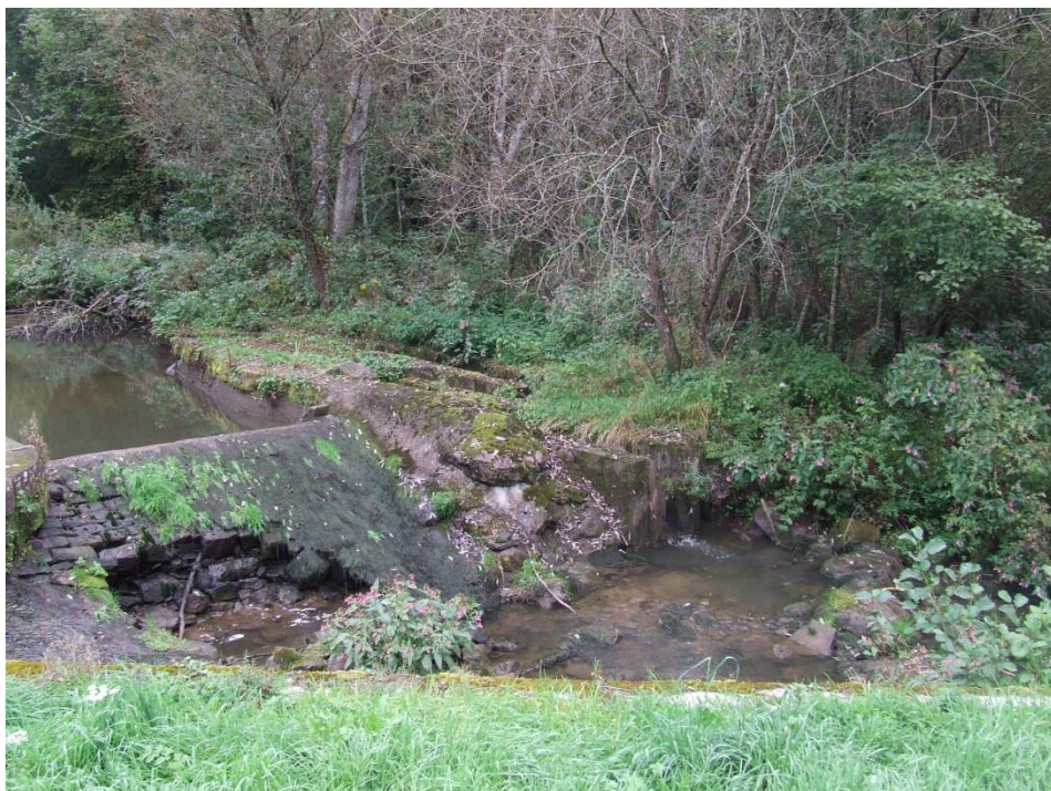
Barrage à poutrelles (partie droite) et seuil fixe (partie gauche). Dégradation importante du parement aval.
