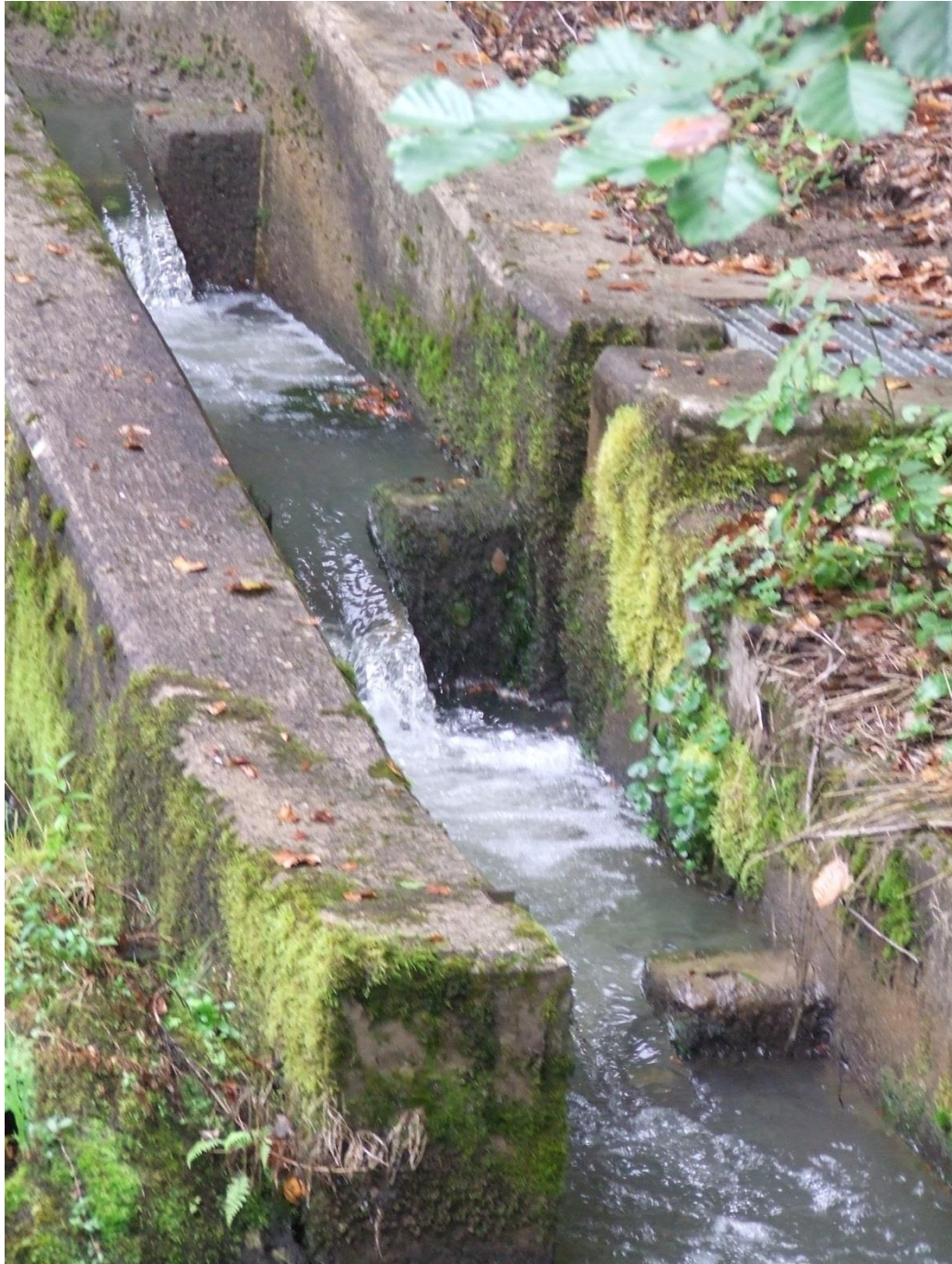
Vue de la passe depuis l'aval, Echancrure d'entrée assez fortement noyée et fonctionnant en jet de surface (débit assez élevé), Echancrures amont en régime totalement dénoyé avec jets plongeants.
