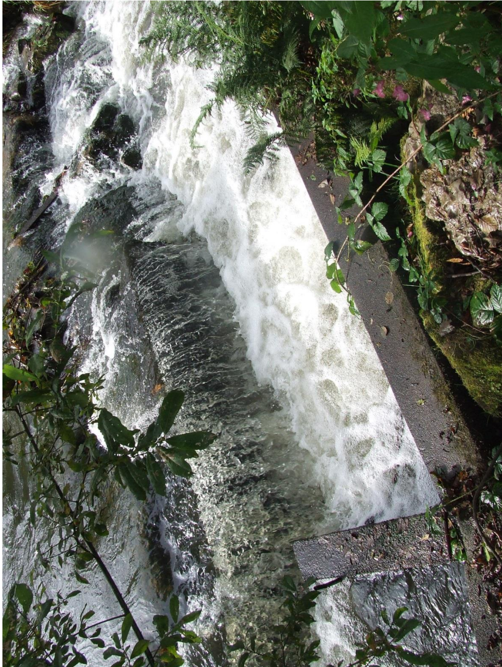
Cloison d'entrée de la passe, turbulences excessives liées au déversement du seuil.
