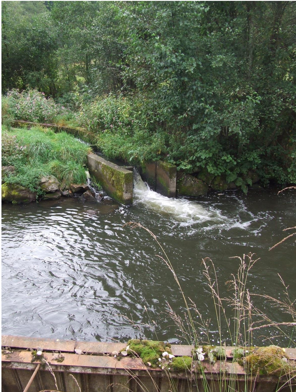
Entrée et partie aval de la passe, exutoire en rive droite de la passe d'un drain reprenant une partie des venues d'eau observées le long de la passe.
