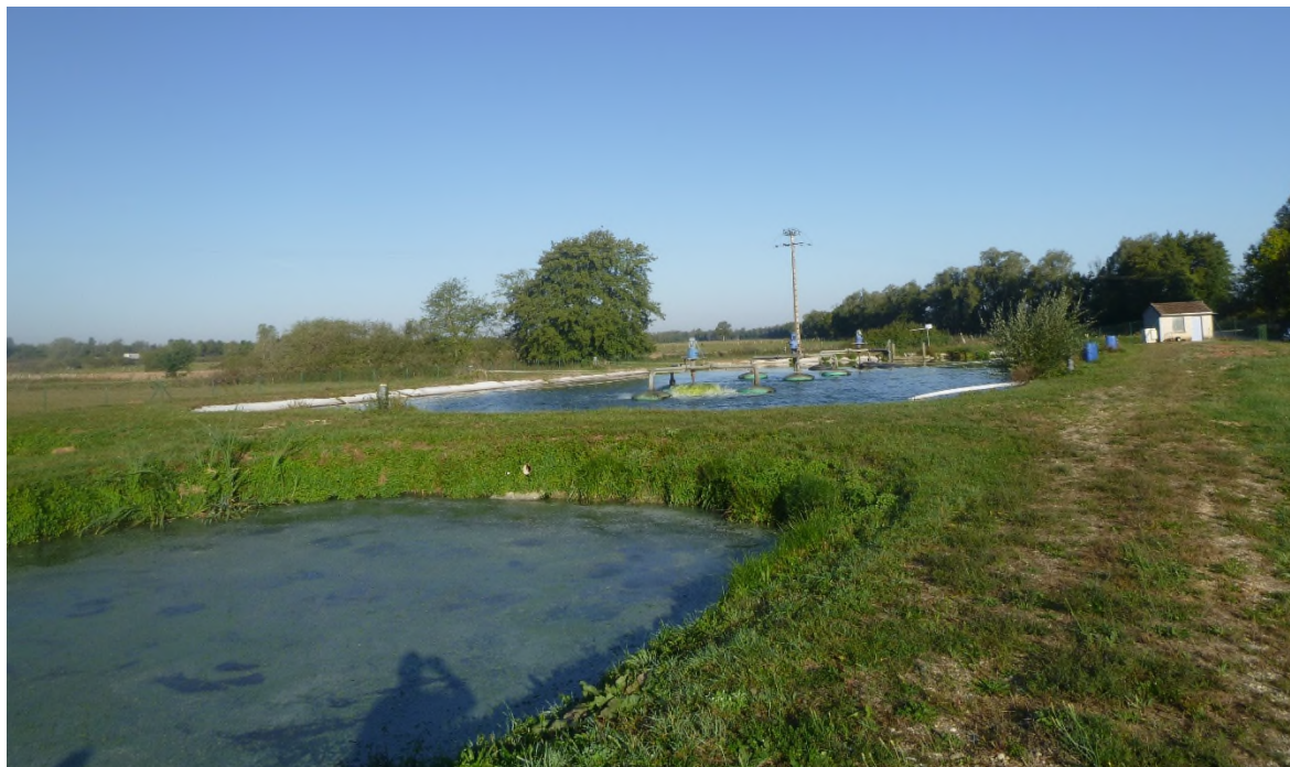
Figure 6 : Station d'épuration d'Ouessières
