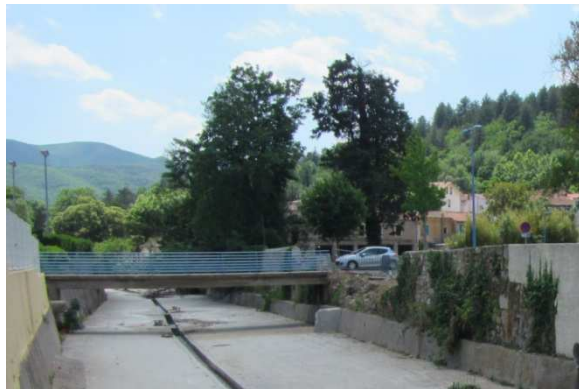
Passerelle de la piscine
