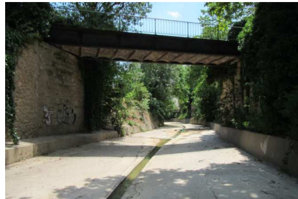
Passerelle de l'allée du Clos du Bitoulet
