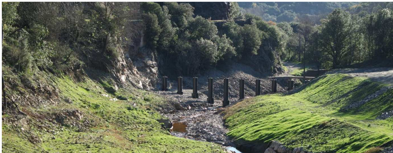
Peigne à embâcles réalisé en lieu et place de l'ancien barrage de la Biconque
