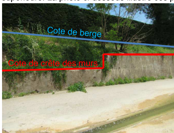
Exemple de mur de soutènement
