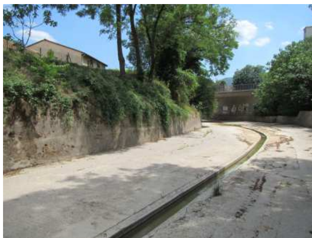
Murs RG au droit du lotissement du Mairal
