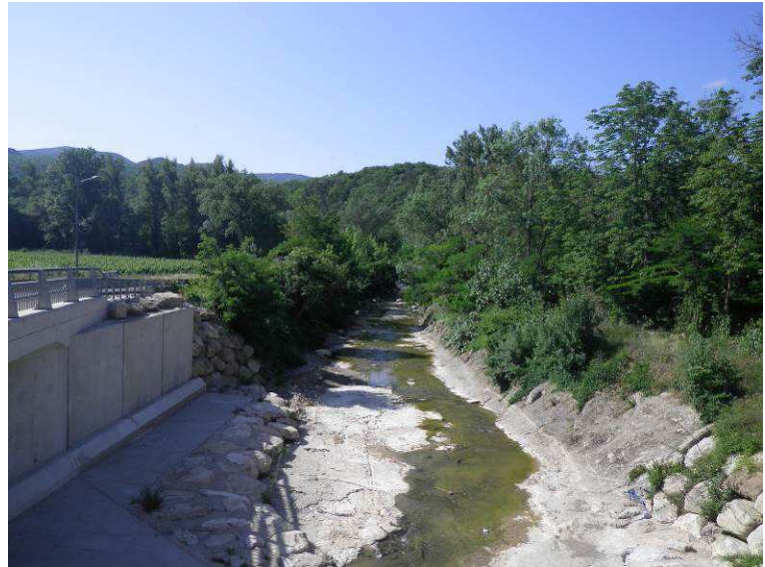
Fond du lit bétonné à la confluence avec l'Orb : étalement de la lame d'eau
