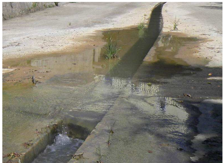
Exemple de seuils au sein du chenal d'étiage
