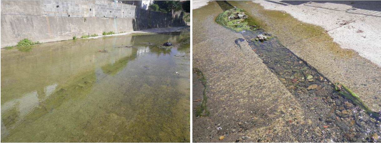
Chenal d'étéage béton obstrués par des sédiments
