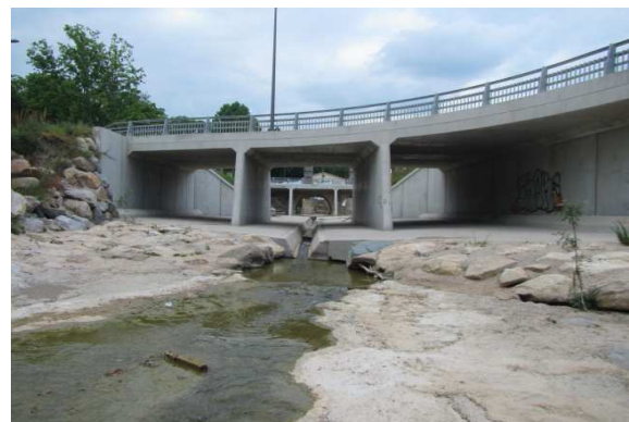
Pont de la RD908 aval
