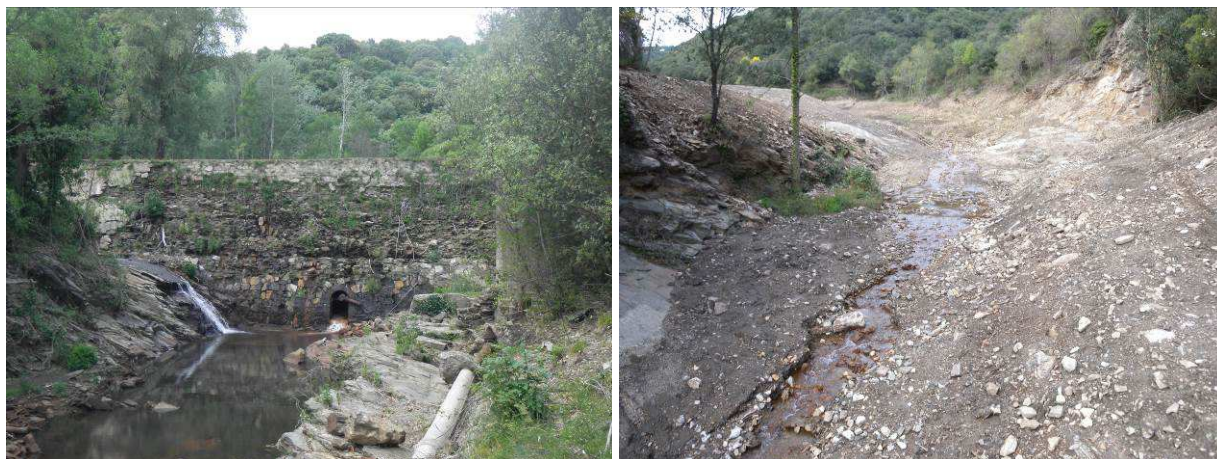
Barrage de la Biconque avant et après dérasement
