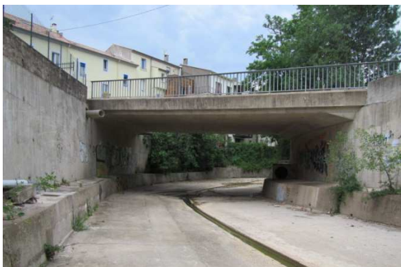
Pont du boulevard Le Mairal
