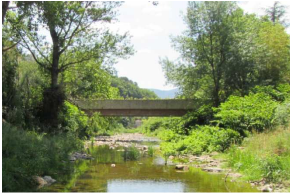
Passerelle de la résidence Plein Soleil
