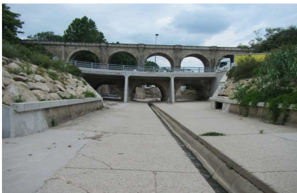
Pont de la RD908 amont
