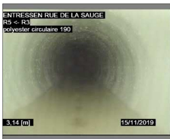
Photo: 5_2A, 00:00:44 3,14m, Photographie générale - / Après gainage
