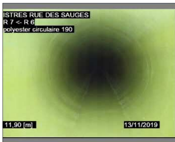
Photo: 2_4A, 00:01:55 11,9m, Photographie générale - / Après gainage
