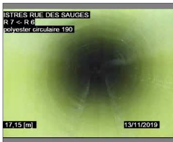
Photo: 2_5A, 00:02:36 17,15m, Photographie générale - / Après gainage
