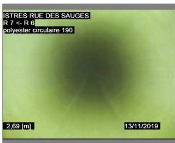
Photo: 2_2A, 00:00:44 2,69m, Photographie générale - / Après gainage
