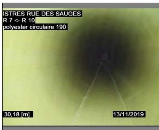
Photo: 3_4A, 00:04:10 30,18m, Photographie générale - / Après gainage
