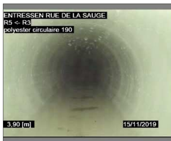
Photo: 5_3A, 00:00:50 3,86m, Photographie générale - / Après gainage
