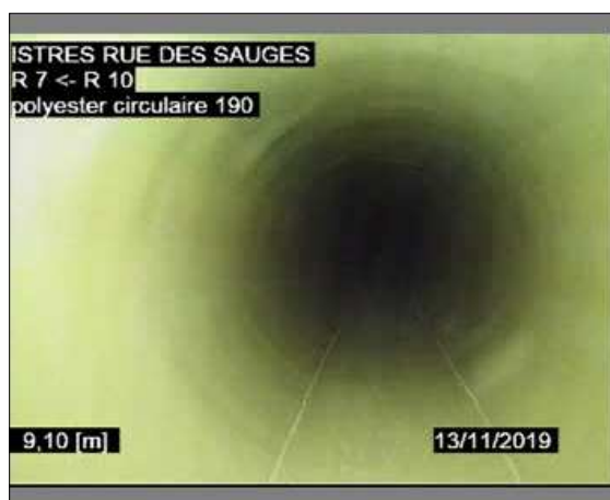
Photo: 3_2A, 00:01:28 9,1m, Photographie générale - / Après gainage
