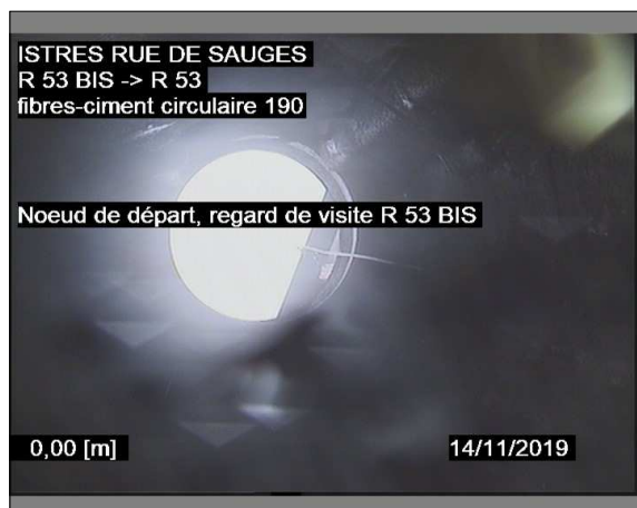
Photo: 4_1A, 00:00:00 0m, Noeud de départ, regard de visite R 53 BIS / APRES GAINAGE
