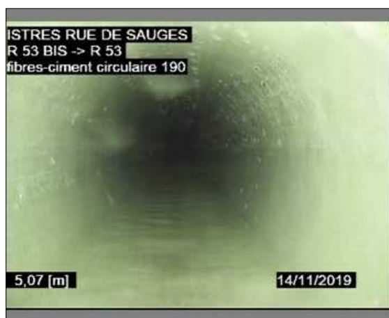
Photo: 4_2A, 00:01:22 5,07m, Photographie générale - / Après gainage
