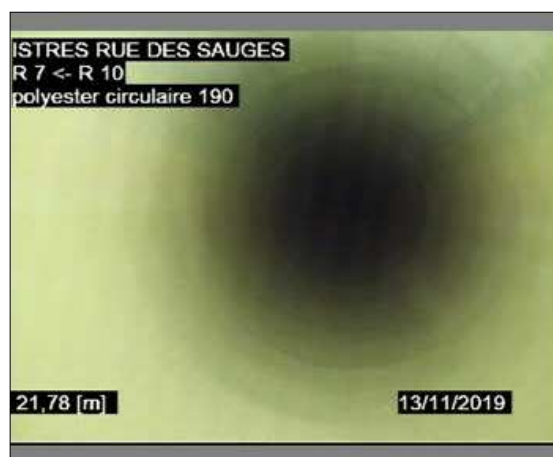
Photo: 3_3A, 00:03:05 21,78m, Photographie générale - / Après gainage
