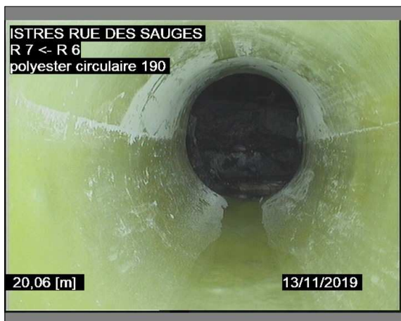
Photo: 6_2A, 00:03:06 23m, Noeud d'arrivée, regard de visite R 6 / APRES GAINAGE
