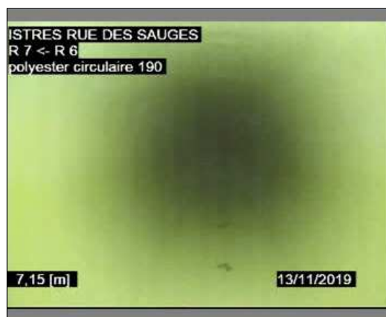
Photo: 2_3A, 00:01:18 7,15m, Photographie générale - / Après gainage
