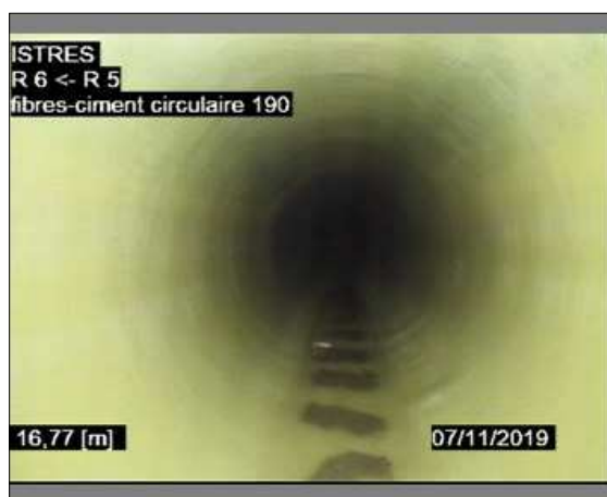
Photo: 1_2A, 00:02:38 16,77m, Photographie générale - / Après gainage
