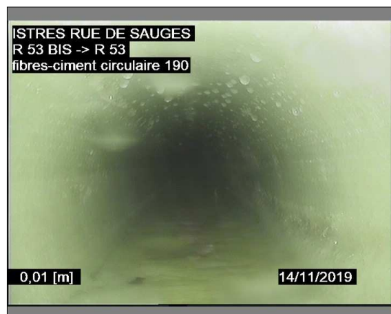
Photo: 4_1B, 00:00:00 0m, Noeud de départ, regard de visite R 53 BIS / APRES GAINAGE
