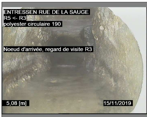
Photo: 9_2A, 00:01:03 5,08m, Noeud d'arrivée, regard de visite R3 / FIN ITV FINALE
