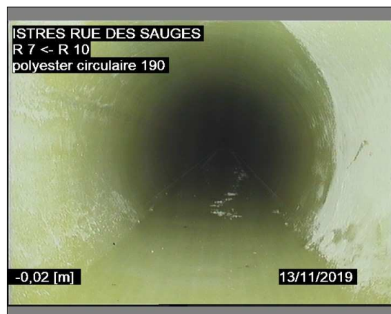
Photo: 7_1B, 00:00:00 0m, Noeud de départ, regard de visite R 7 / APRES GAINAGE
