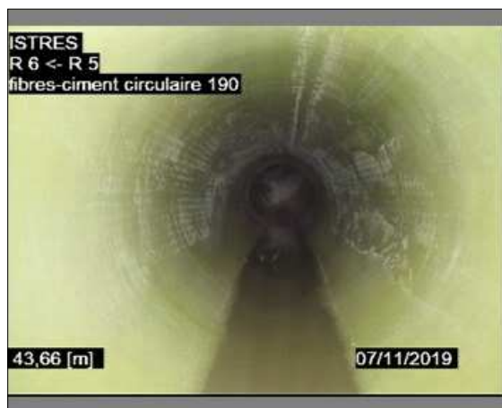
Photo: 1_4A, 00:06:07 43,61m, Photographie générale - / Après gainage
