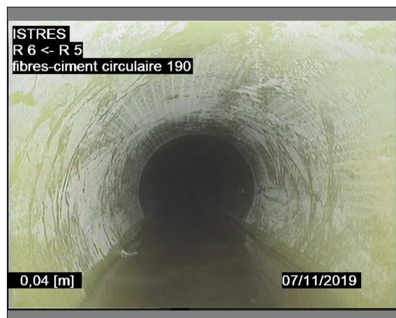
Photo: 3_1B, 00:00:00 0m, Noeud de départ, regard de visite R 6 / AVANT GAINAGE
