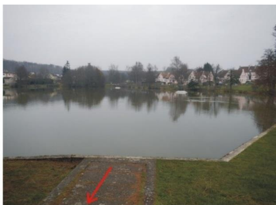
Etang de la Poche. Vue depuis l'extrémité Sud Trop plein de l'étang
