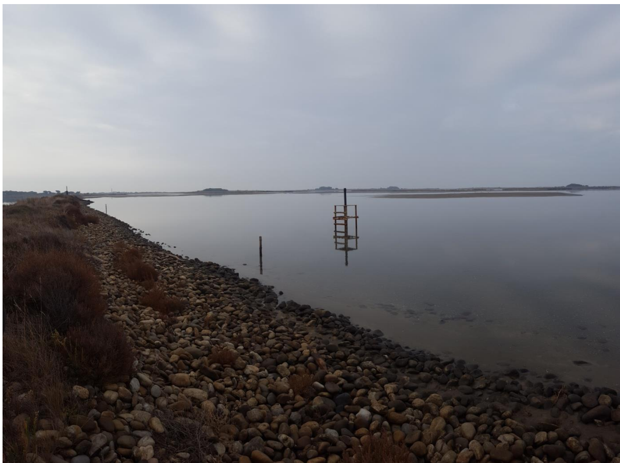
Figure 9 : photographies de l'installation de la sonde CTD dans l'étang de Sablons (sonde n°2 sur la Figure 7).
