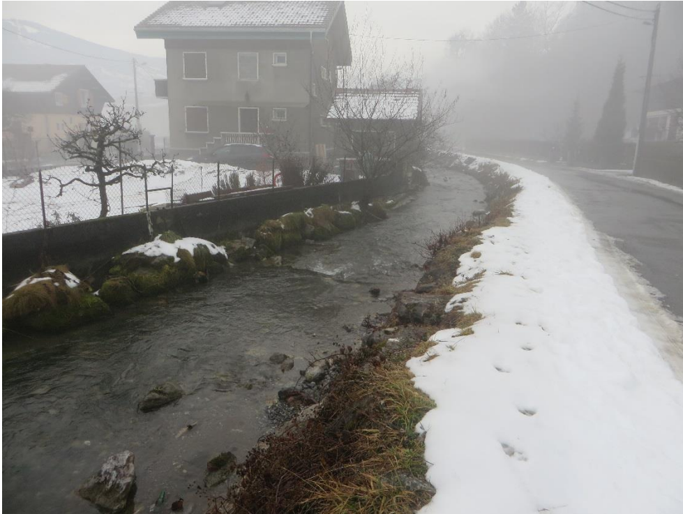
Figure 21 : Illustration aux environs du PK 2.080 – vue vers l'aval
