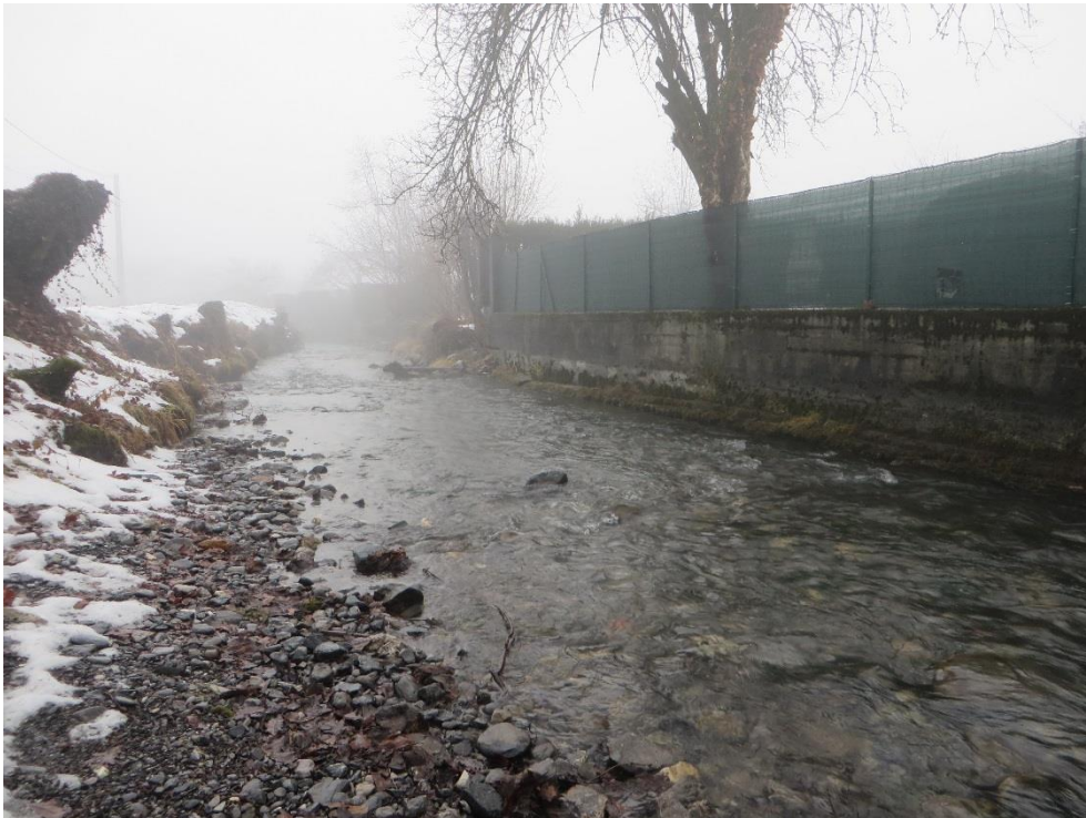
Figure 25 : Illustration aux environs du PK 1.620 – vue vers l'aval
