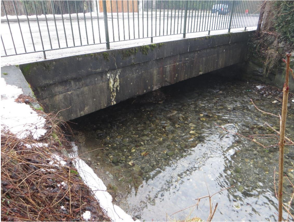
Figure 41 : Ouvrage OH5 – avenue des Grandes Platières
