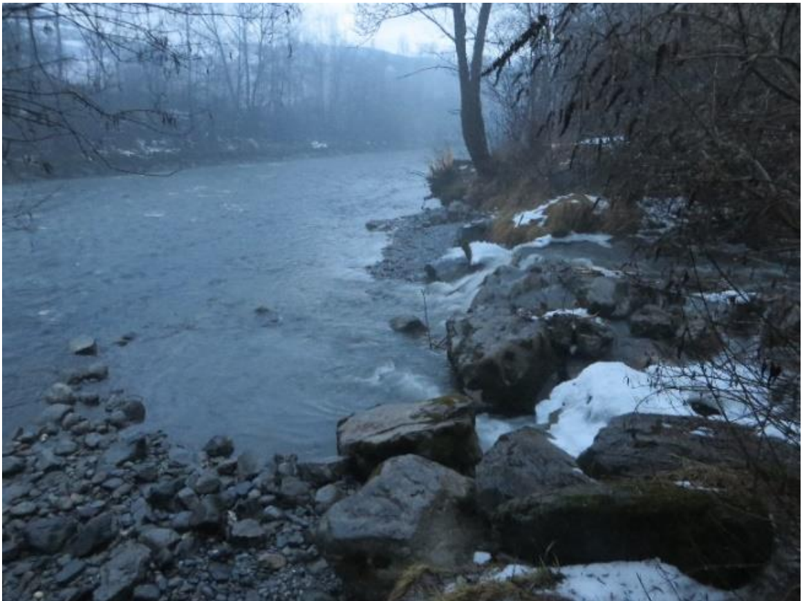
Figure 42 : Seuil à la confluence
