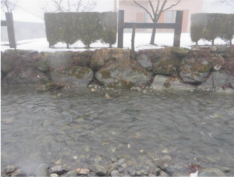
Figure 27 : Illustration à l'amont du PK 1.400
