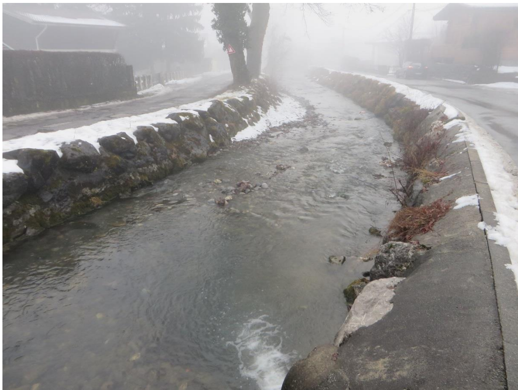
Figure 15 : Illustration d'un profil en travers avec murs
