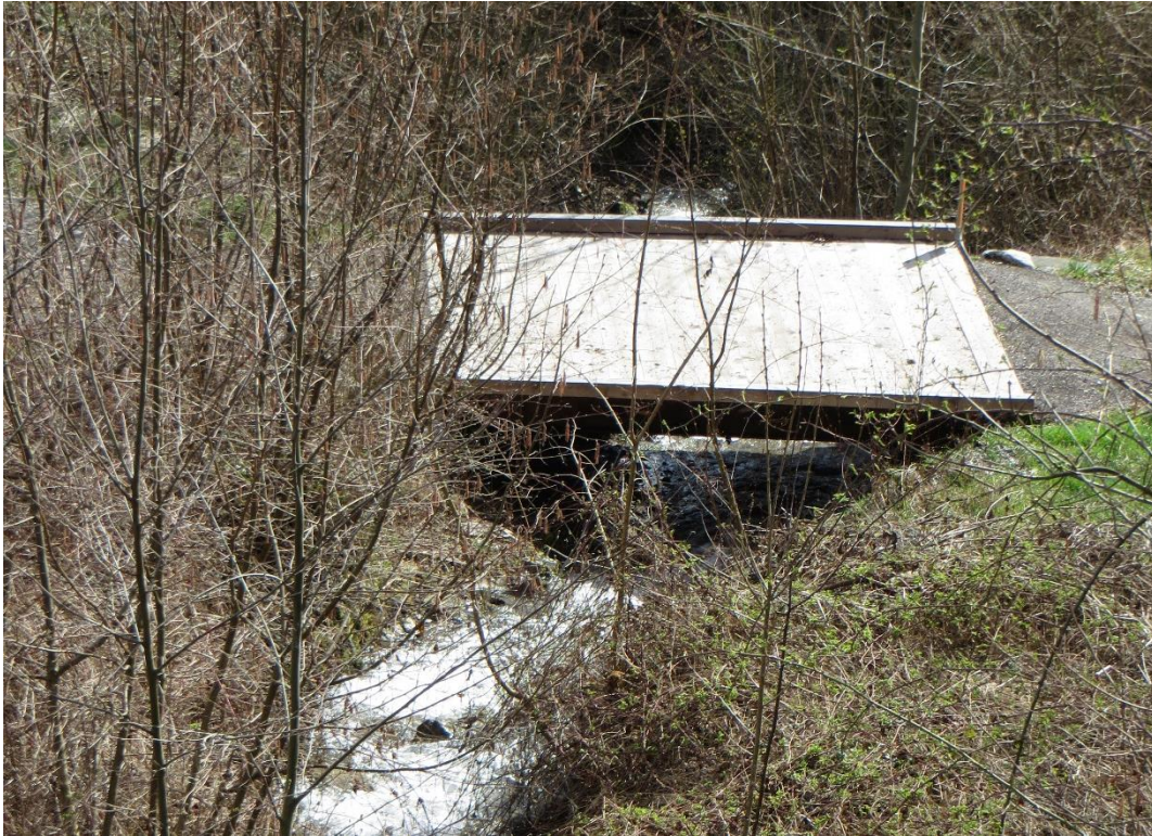
Figure 50 : Secteur en amont du cône où les laves torrentielles se sont répandues
