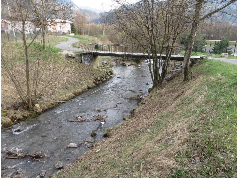
Figure 35 : Illustration aux environs du PK 0.240 – vue vers l'aval
