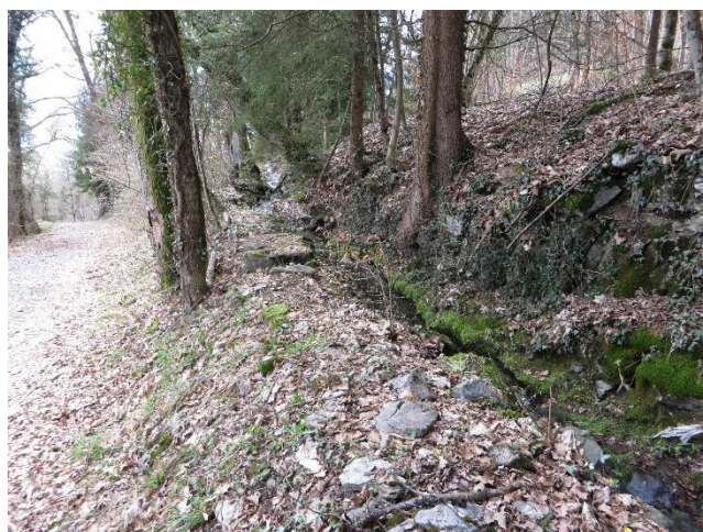
Tronçon canalisé et dérivé – manque d'entretien et points bas – débordements potentiels sur Maffray
