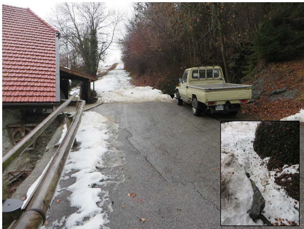
Premier ouvrage pouvant s'obstruer et créer des débordements sur le quartier de la Motte
