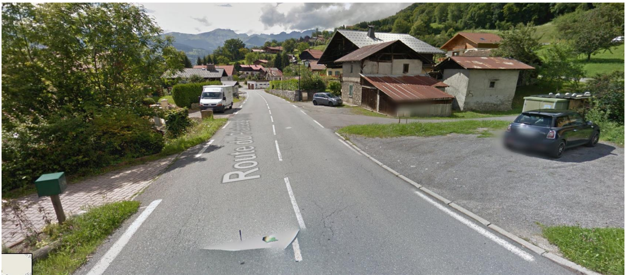
Passage sous la RD43 – route du Plateau d'Assy – écoulements possibles en direction du centre bourg – source google
