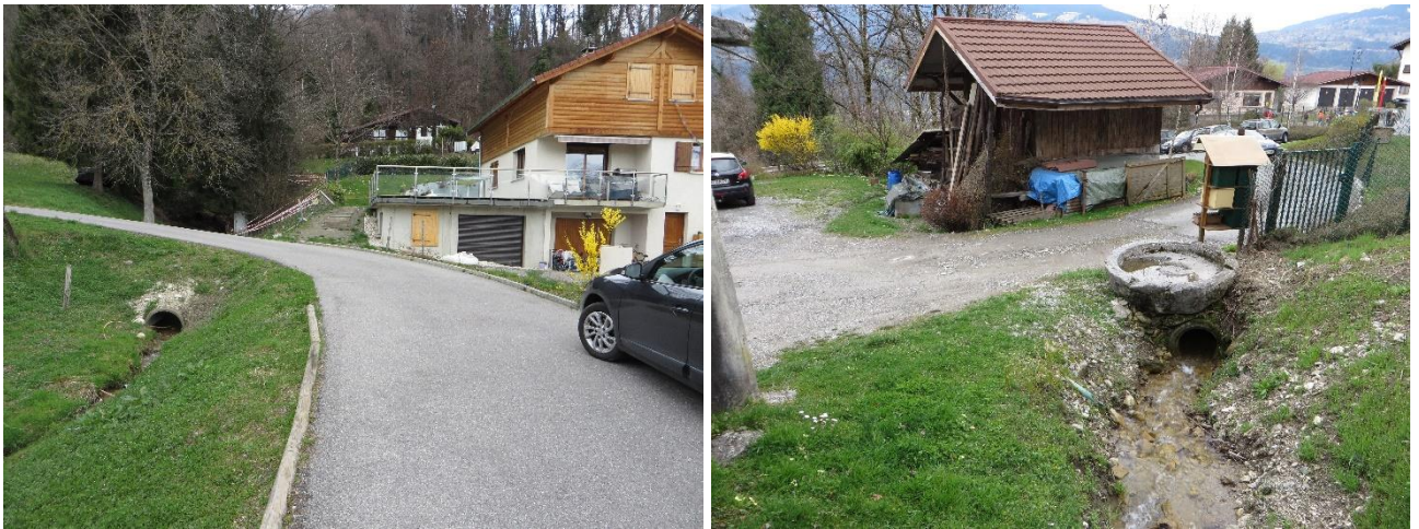
Passages busés limitants pouvant engendrer des débordements en direction de bâtiments
