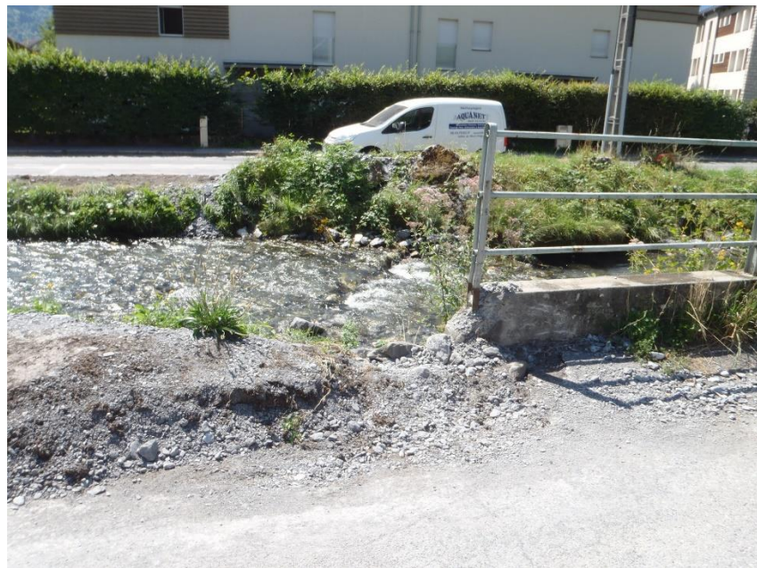
L'Ugine au PK 2.250, vue depuis la rive droite – mai 2015 – photo SM3A
