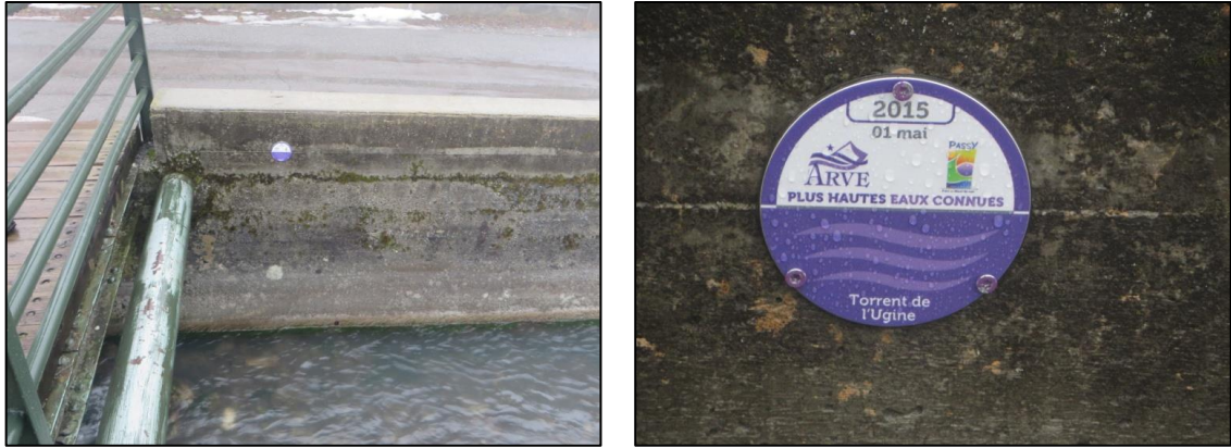
Figure 7 et 8 : Repère de crue sur l'Ugine au niveau de la passerelle reliant la rue de la Couttetaz à la rue de la Freille – Idealp 2017
