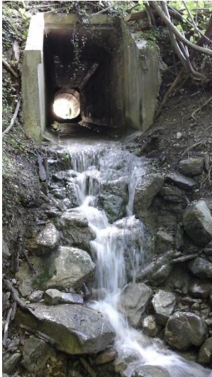
Passage busé puis chute
