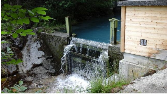
Microcentrale vue aval
