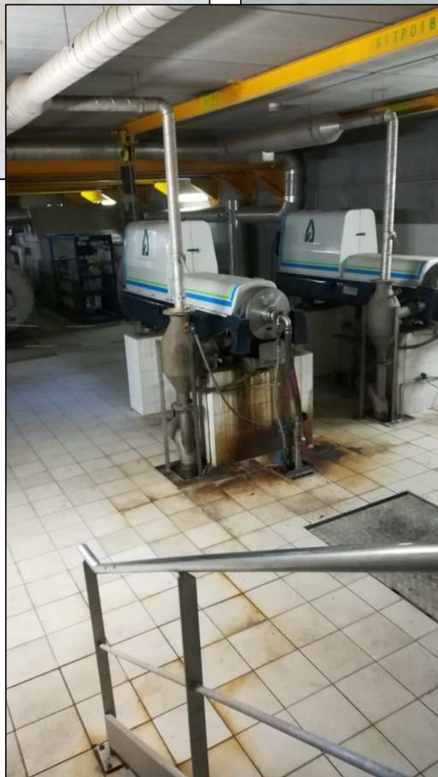
Figures 62, 63 et 64 : Tambours d'épaississement et centrifugeuses
