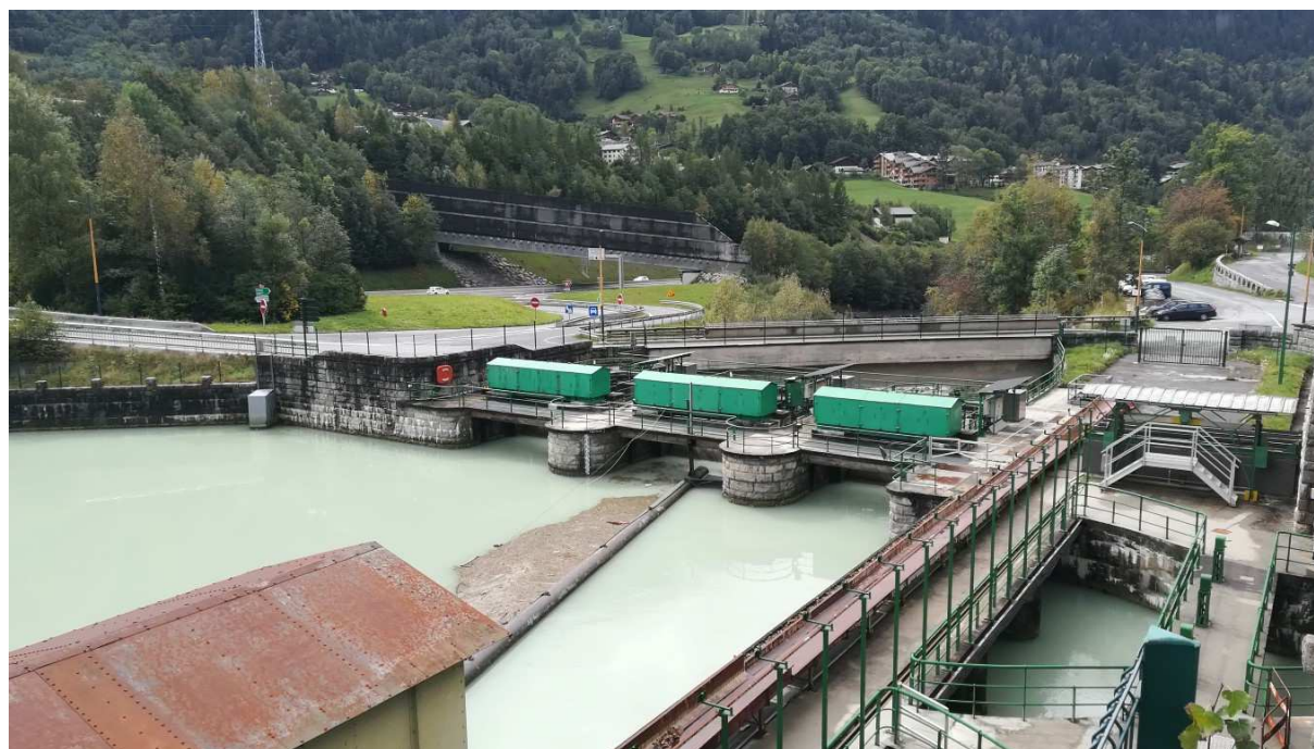
Figure 39 : Retenue EDF des Houches
