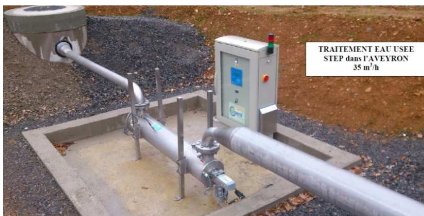
Figure 95 : Exemple de système de désinfection par ultra violet
