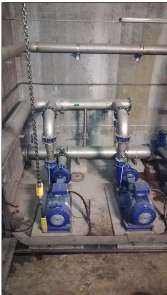
Figures 67 et 68 : Pompes eau traitée vers barrage EDF et pompes d'eau de lavage des biofiltres
