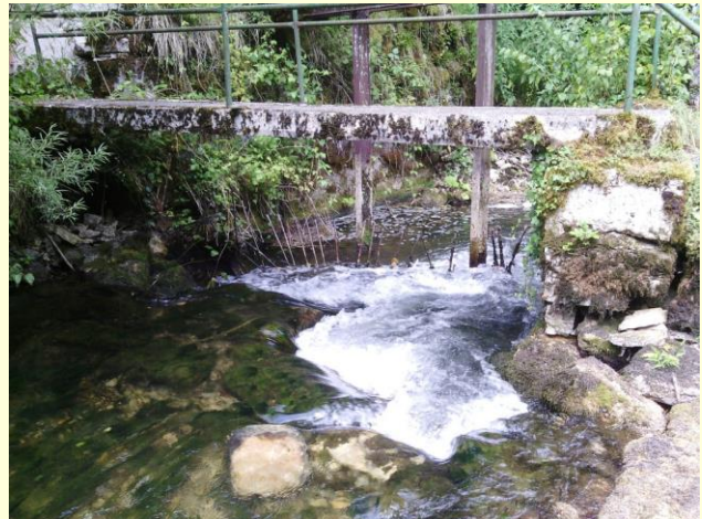
Prise d'eau dérivant l'essentiel du débit
