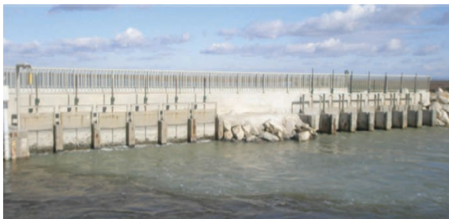
Figure 11 : Vannes coulissantes du pertuis de la Fourcade (MRM)
