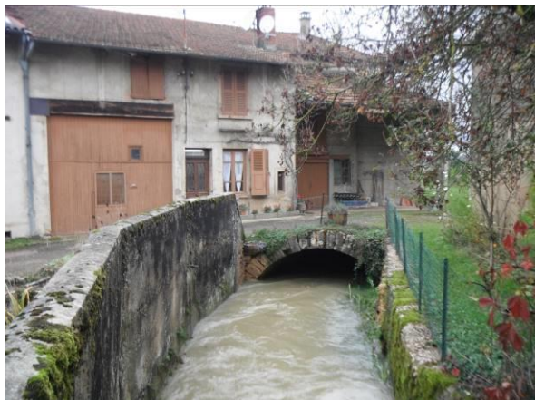
Figure 5 : Illustration de la zone couverte au cœur du hameau de la Championnière puis des berges dont le faciès abrupt et la nature (béton lisse) favorisent l'accélération des écoulements et la banalisation du milieu (Clichés SBVA et Biotec – 15 novembre 2014 et Avril 2016)
