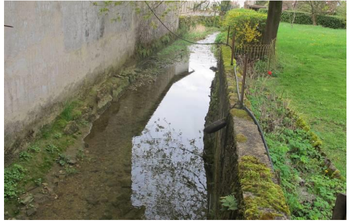
Figure 5 : Illustration de la zone couverte au cœur du hameau de la Championnière puis des berges dont le faciès abrupt et la nature (béton lisse) favorisent l'accélération des écoulements et la banalisation du milieu (Clichés SBVA et Biotec – 15 novembre 2014 et Avril 2016)
