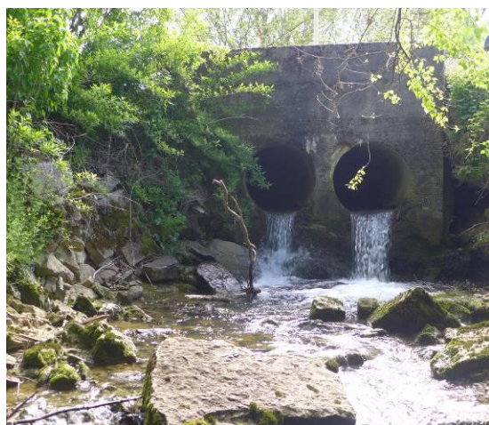
Figure 6 : Illustration de l'ouvrage de franchissement de la voirie communale totalement infranchissable pour les flux biologiques (Clichés Biotec – Avril 2016)
