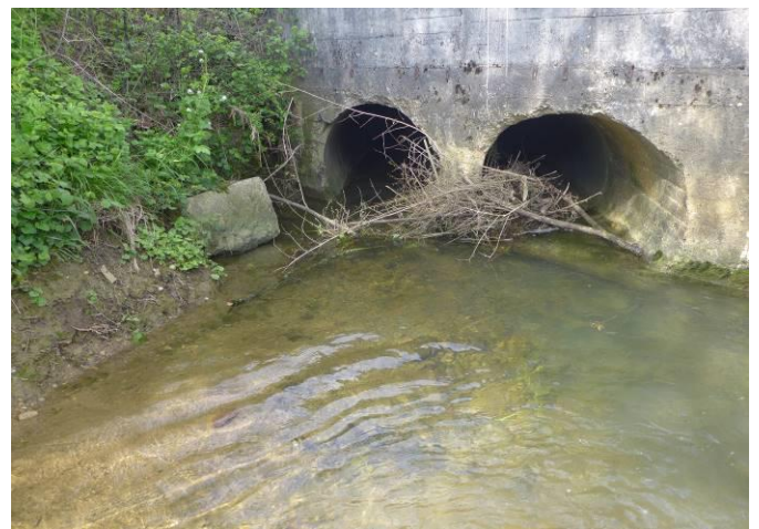
Figure 6 : Illustration de l'ouvrage de franchissement de la voirie communale totalement infranchissable pour les flux biologiques (Clichés Biotec – Avril 2016)
