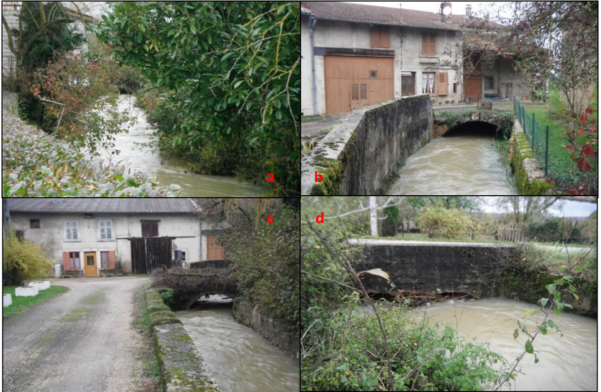
Figure 12 : Illustration de quatre des cinq ouvrages de franchissement du Nantay dans la traversée de la Championnière avec notamment l'arche sous bâtiment (photo b) et les deux canalisations diamètre 1000 sous la voirie communale (photo d), tous deux concernés par des mises en charge dès des crues courantes (les photographies ont été réalisées en novembre 2014 par le SBVA pour un événement pluvieux de 41 mm, soit une période de retour nettement inférieure à la décennale si on considère une durée de pluie de 12 ou 24 heures)
