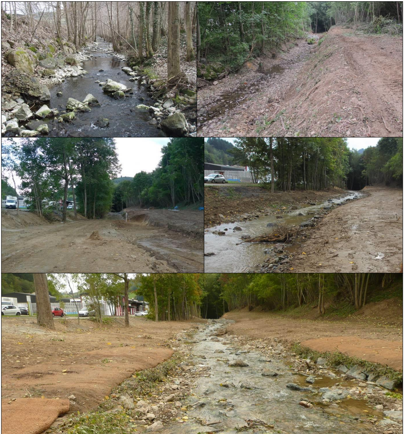
Figure 22 : Vue successive des travaux de léger déviation et de rehaussement du lit de la Turdine à l'aval du seuil dérasé des Blanchisseries, à Tarare (dept.69) - chantier finalisé en fin d'année 2012 / images chantier « avant » (image haute et gauche/ février 2008), puis « pendant » (images haute et droite, puis médianes/ sept. 2012) ainsi qu'« en fin de chantier » (image basse/ oct. 2012) - Conception, photos et maîtrise d'œuvre : Equipe d'ingénieurs d'étude de Biotec.
