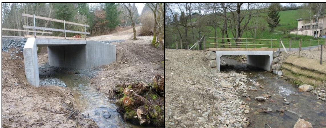
Figure 21 : Exemples d'ouvrage de type PIPO mis en place sur la Dronne (commune de Bussière Gallant-87, photo gauche) puis sur le Boussivre (Commune de Saint Marcel l'Eclairé-69, photo droite), maîtrise d'œuvre assurée par les soins de l'équipe BIOTEC.
