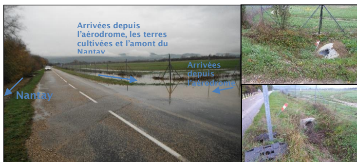
Figure 9 : Illustrations des débordements sur voirie survenus en novembre 2014 (source : SBVA novembre 2014) et des ouvrages de gestion des eaux pluviales vraisemblablement insuffisant (source : Biotec octobre 2016)
