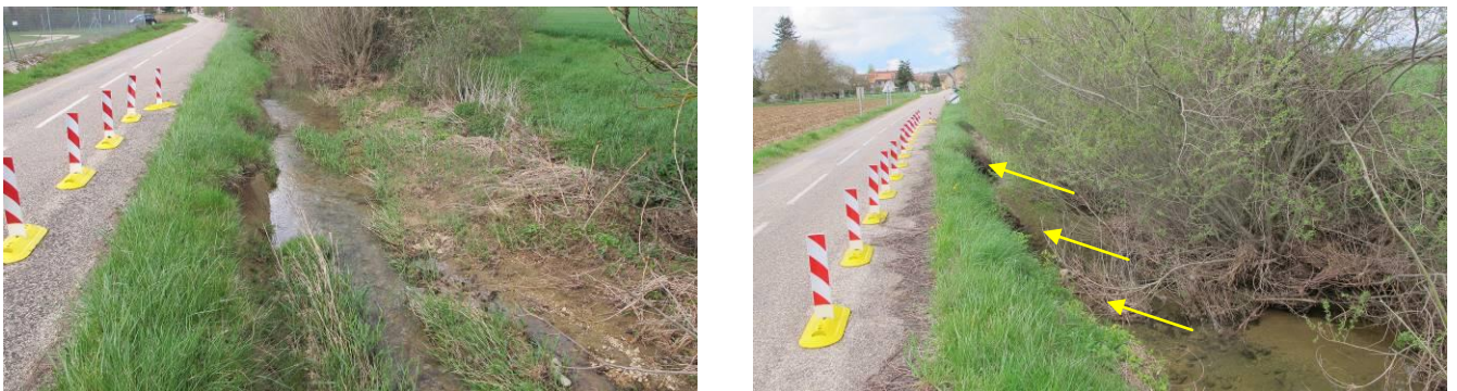
Figure 3 : Illustration des « fronts d'érosion » en rive gauche qui, à court terme, vont remettre en cause la stabilisation de l'enrobé de la voirie puis illustration de la végétation arbustive qui par son système aérien contribue à jouer le rôle d'épis en renvoyant le flux vers la berge opposée - Clichés Biotec, avril 2016.
