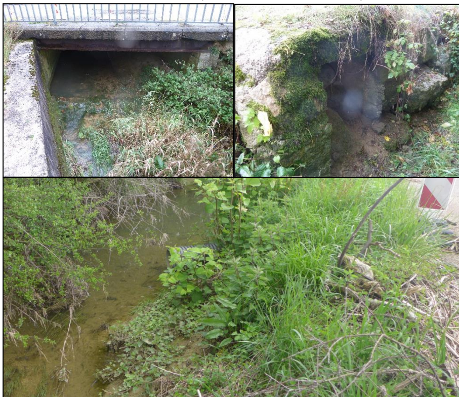
Figure 18 : Ouvrage OA3, permettant le franchissement de la RD77 par le Nantay (source : BIOTEC octobre 2016) et Illustrations d'un des exutoires dans le Nantay des canalisations diamètre 300 franchissant la RD77 (source : BIOTEC octobre 2016)
