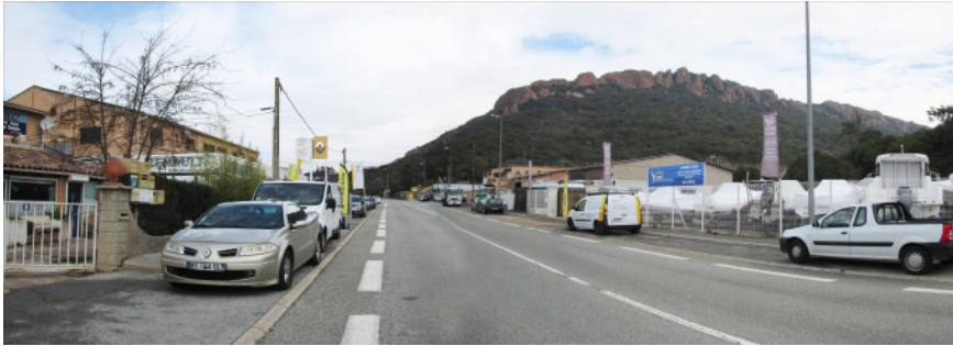
1 - Avenue de Gratadis (RD100) très fréquentée traversant la zone artisanale
