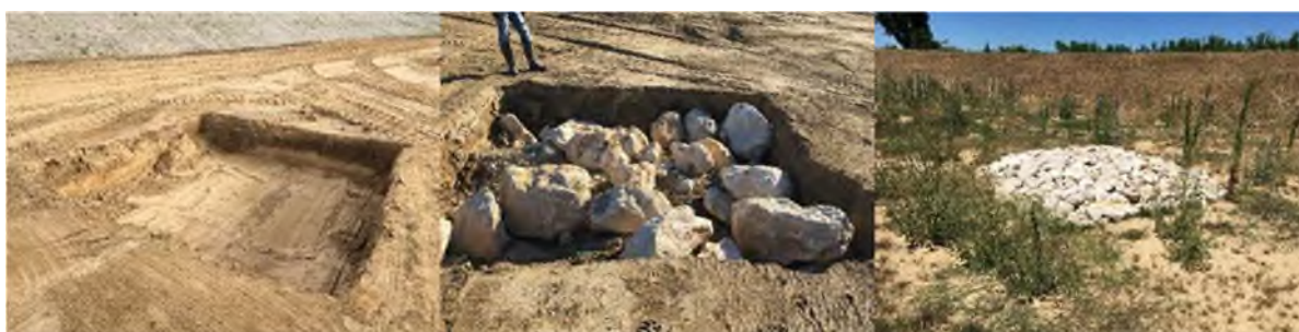
FIGURE 50 : PHOTOS A DIFFERENTES ETAPES DE LA CONSTRUCTION D'UN PIERRIER SUR UNE RISBERME A DESTINATION DES REPTILES
