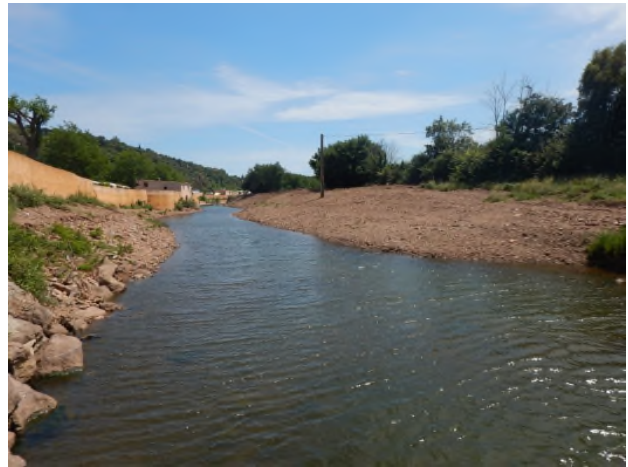
Vue vers l'aval depuis le gué
