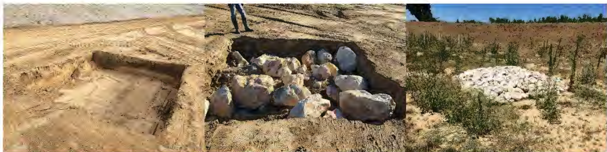
Photos 9, 10 et 11 : Photos à différentes étapes de la construction d'un pierrier sur une risberge à destination des reptiles.
