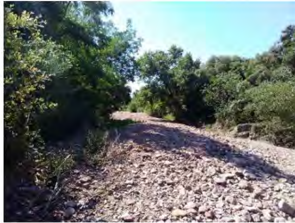
Photo A6-25 : Zone 1 - La Cabre aval.
