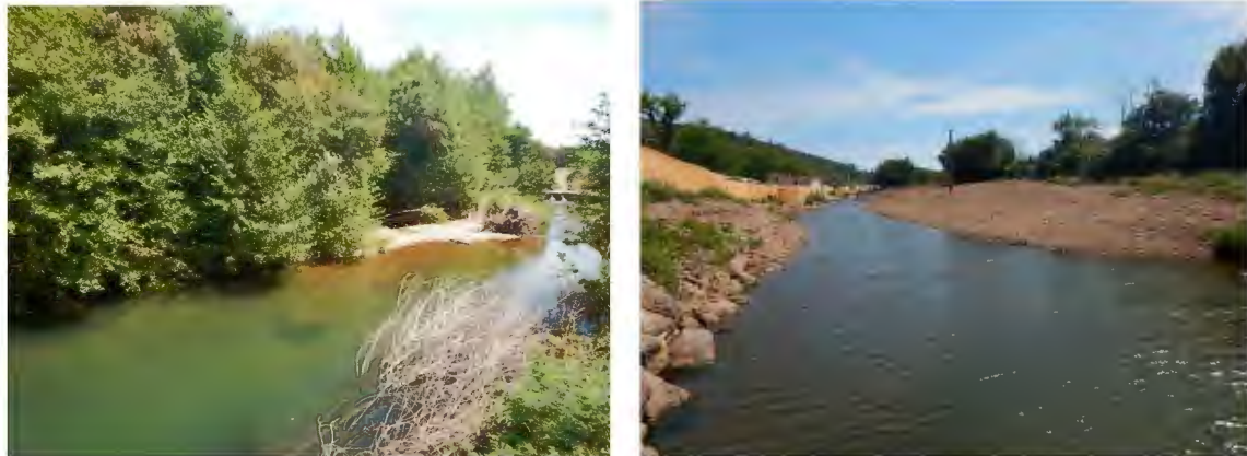
Photo 2 : Partie aval du secteur d'aménagement
