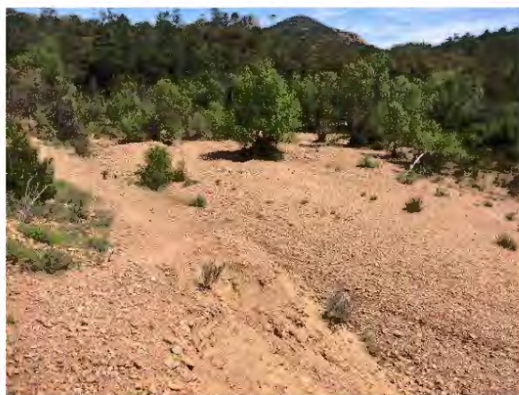
Photo A6-22 : Berge rive droite fortement érodée.
