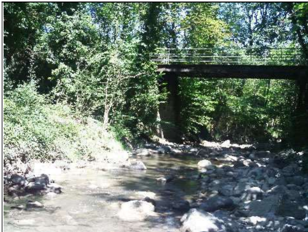
▲ Vue d'un radier.
