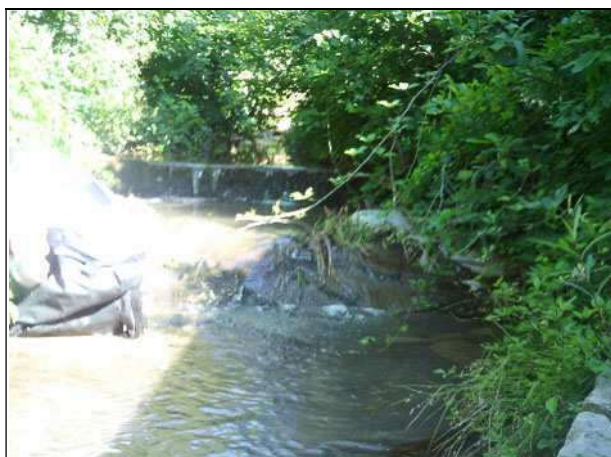
▲ Vue d'un radier.
