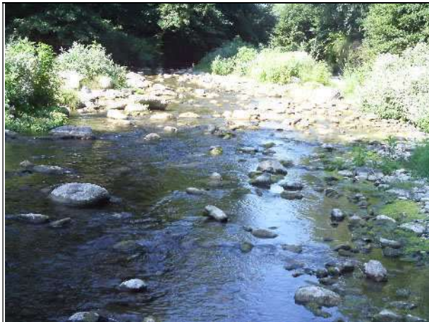
▲ Vue d'un radier.
