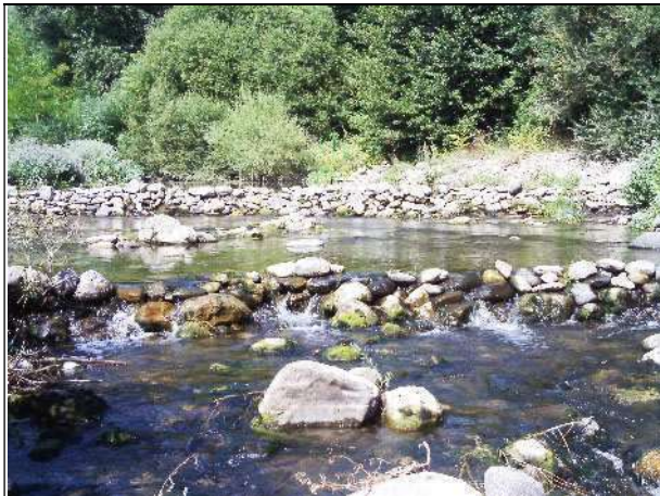
▲ Vue d'un radier.
