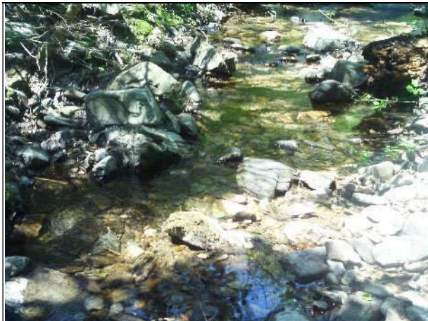
▲ Vue d'un radier.
