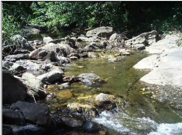
▲ Vue d'un radier.
