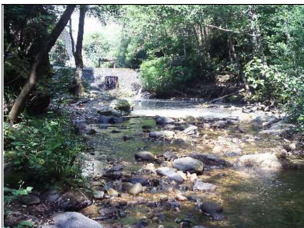
▲ Vue d'un radier.
