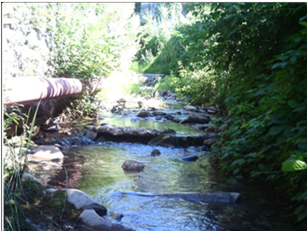
▲ Vue vers l'amont depuis l'accès
