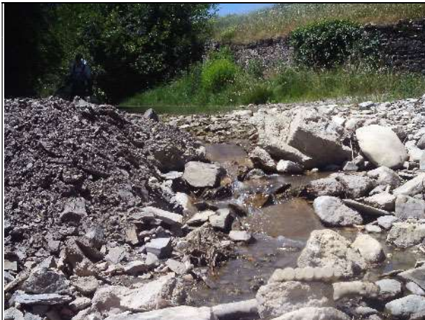
▲ Vue d'un radier.
