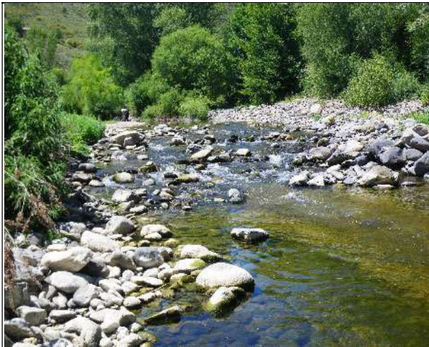
▲ Vue d'un radier.
