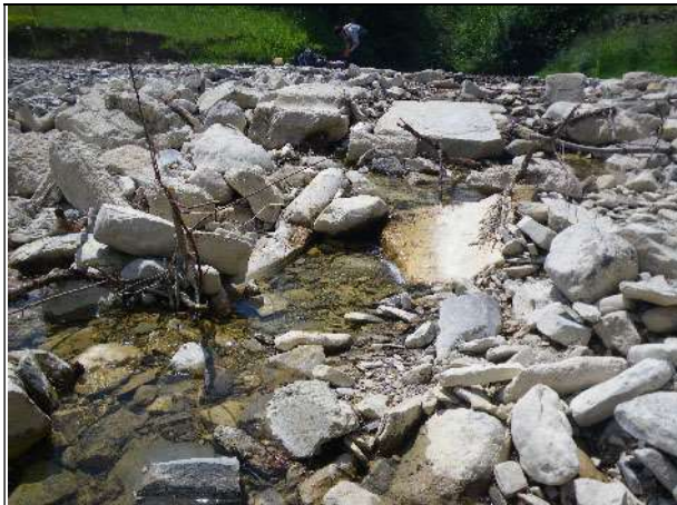
▲ Vue d'un radier.
