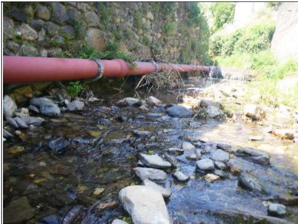
▲ Vue d'un radier.
