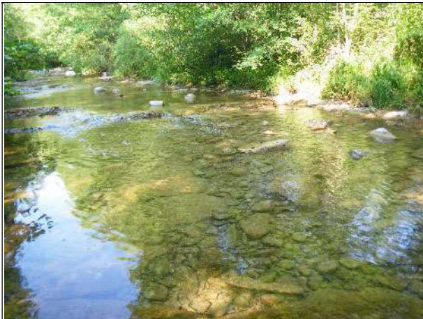
▲ Vue d'un radier.
