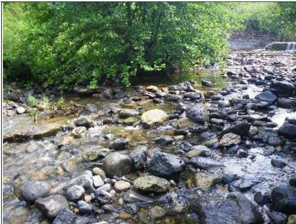
▲ Vue d'un radier.
