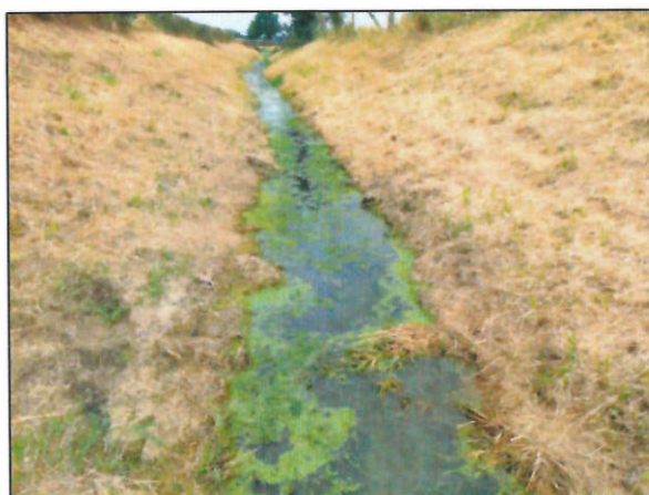
La Breux – Vue Amont
