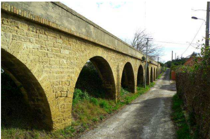
Aqueduc dans lequel le canal est busé, en aval de la voie ferrée
