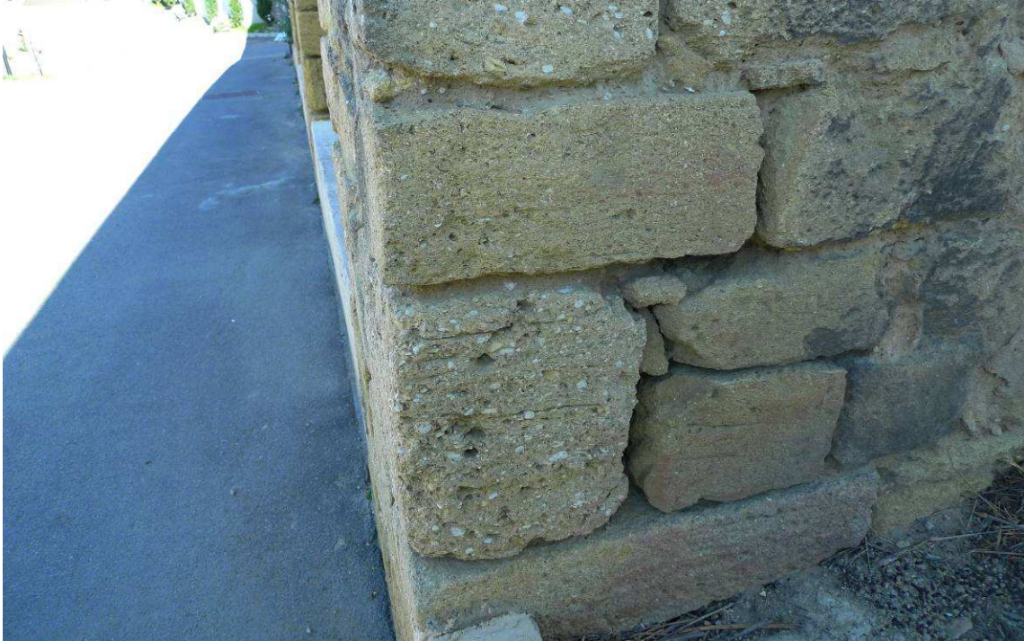
Erosion éolienne des pierres et des joints au pied des piles
