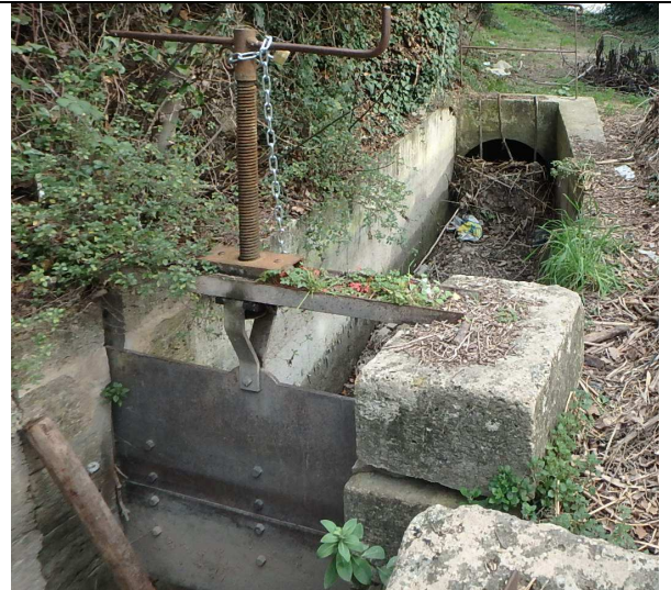
Vanne de prise de la Dent et départ de la buse DN1000
