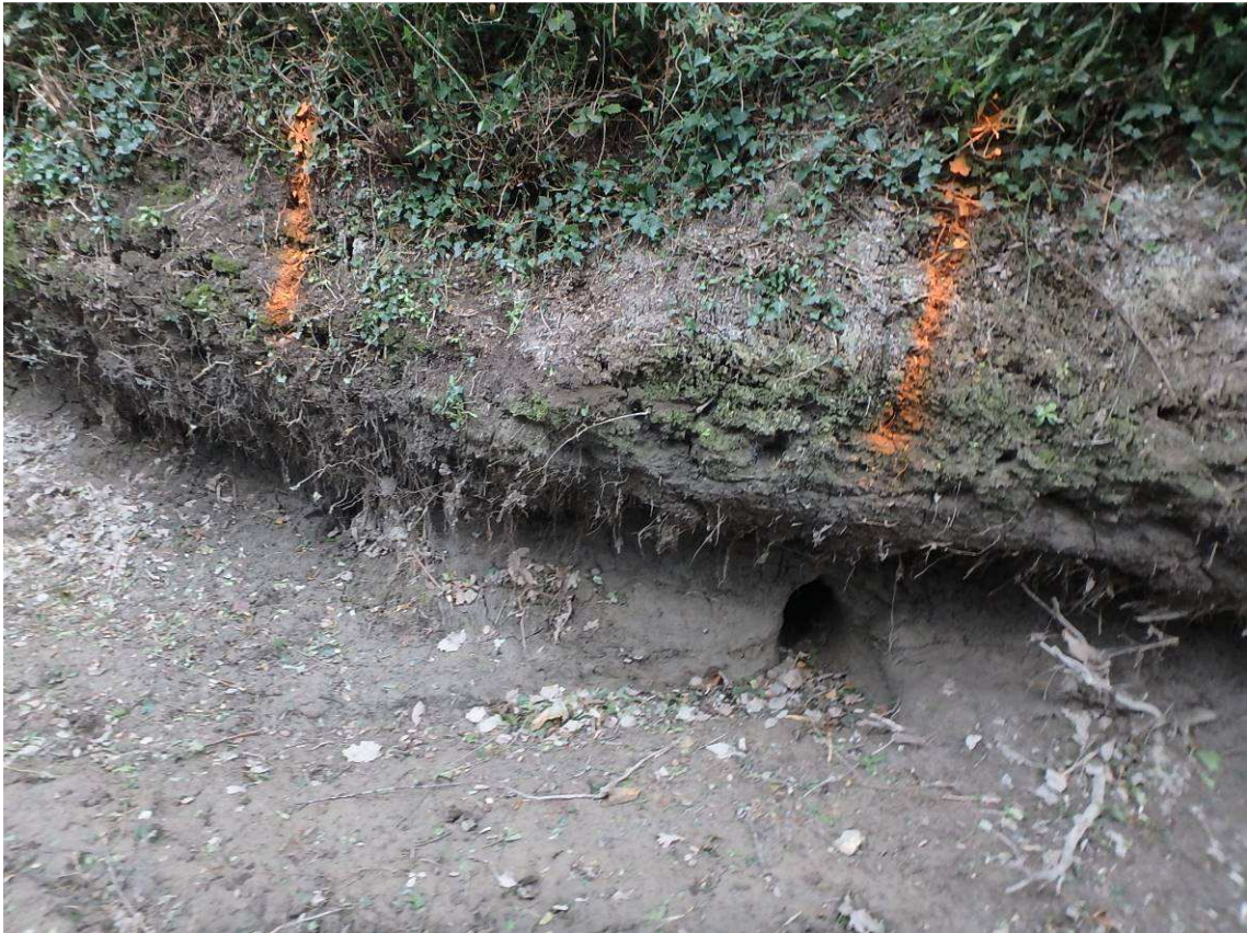
Terrier dans la berge du canal commun
