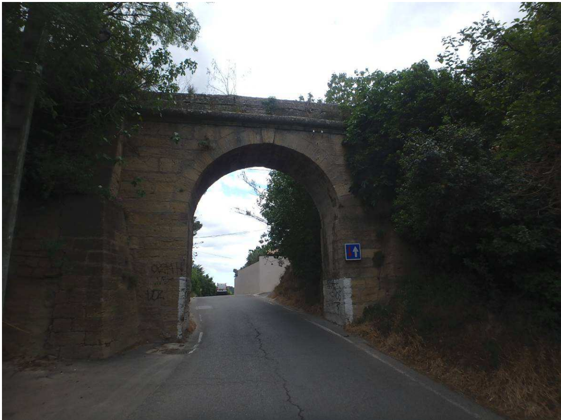
Vue de l'ouvrage face Ouest
