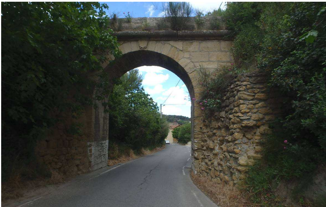
Vue de l'ouvrage face Est
