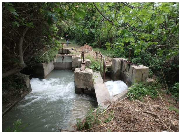
Vue du partiteur en eau. Le remous en rive gauche correspond à l'arrivée du canal du Pougnois
