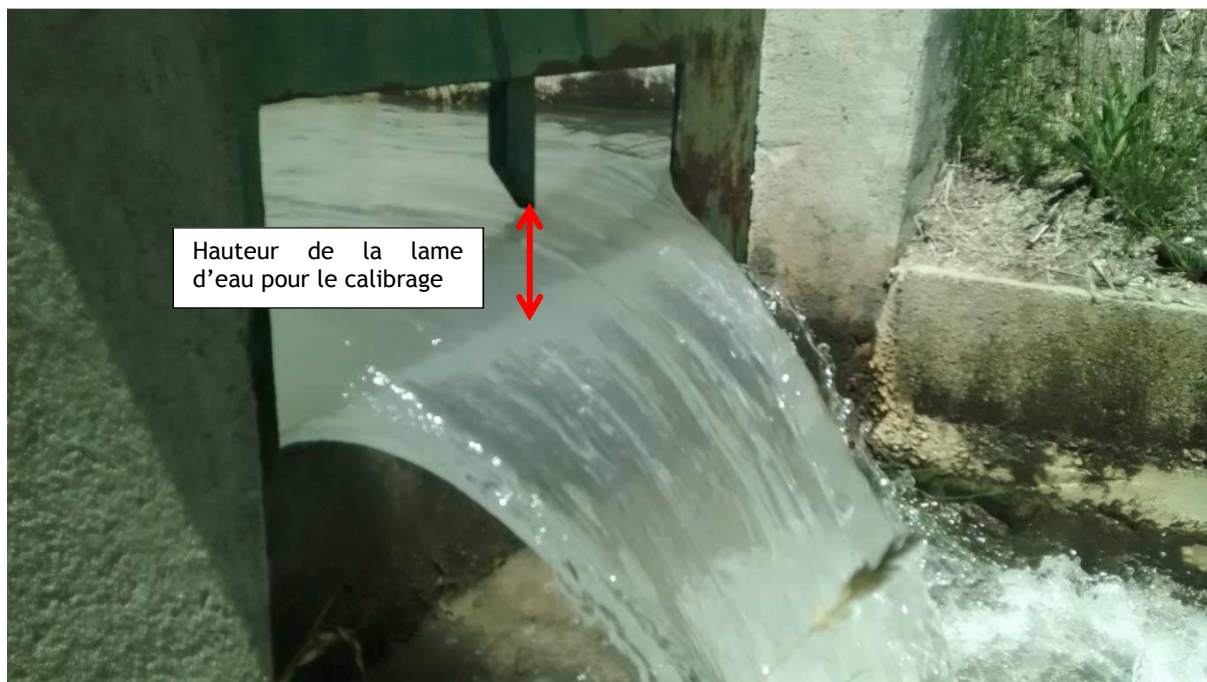
Figure 2: Lame d'eau à mesurer pour le calibrage des prises
