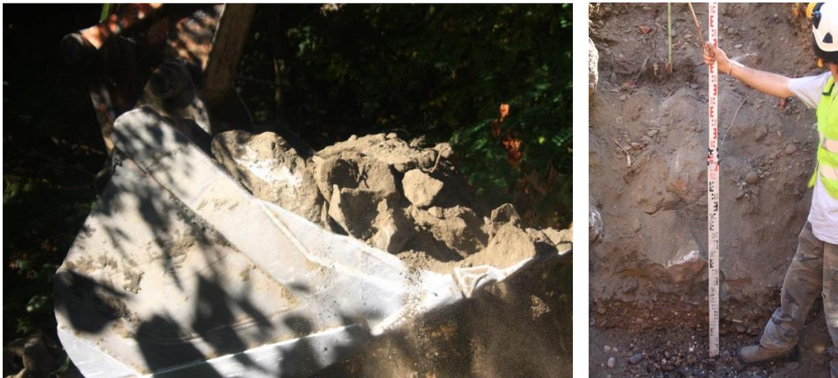
Enrochement déblayés sur la traverse n°2 et vue du sondage de la traverse n°3.
