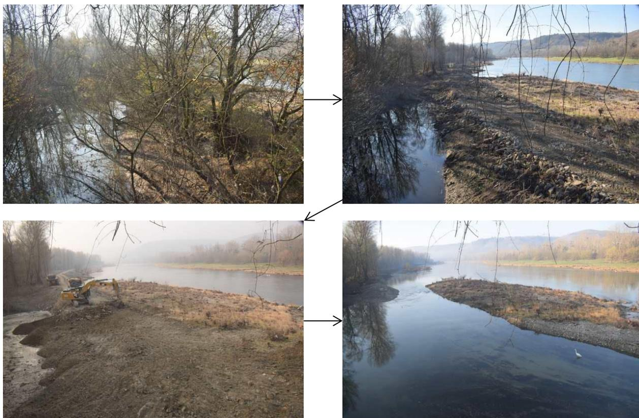
Travaux de remobilisation des casiers de l'île des Graviers, enlèvement de la digue longitudinale (Péage-de-Roussillon, Association des Amis de l'île de la Platière, 2017).
