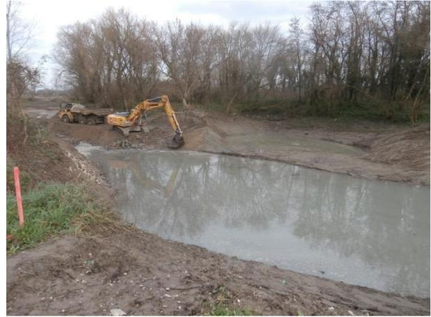
Creusement d'un bras secondaire au sein de casiers Girardon (lône de Prieuré, Péage-de-Roussillon, 2014).
