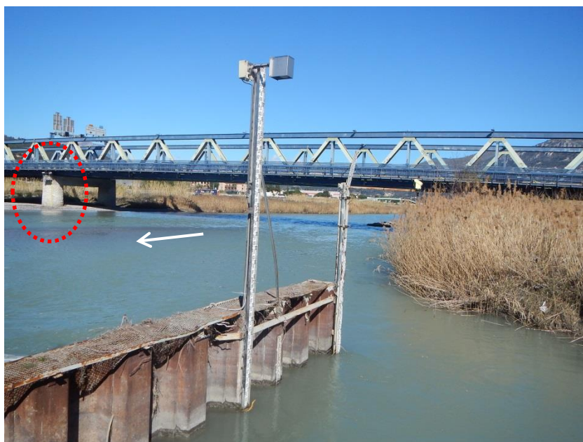
Figure 28 : Mesures de niveaux de la station hydrométrique de la Manda, vue depuis la microcentrale
