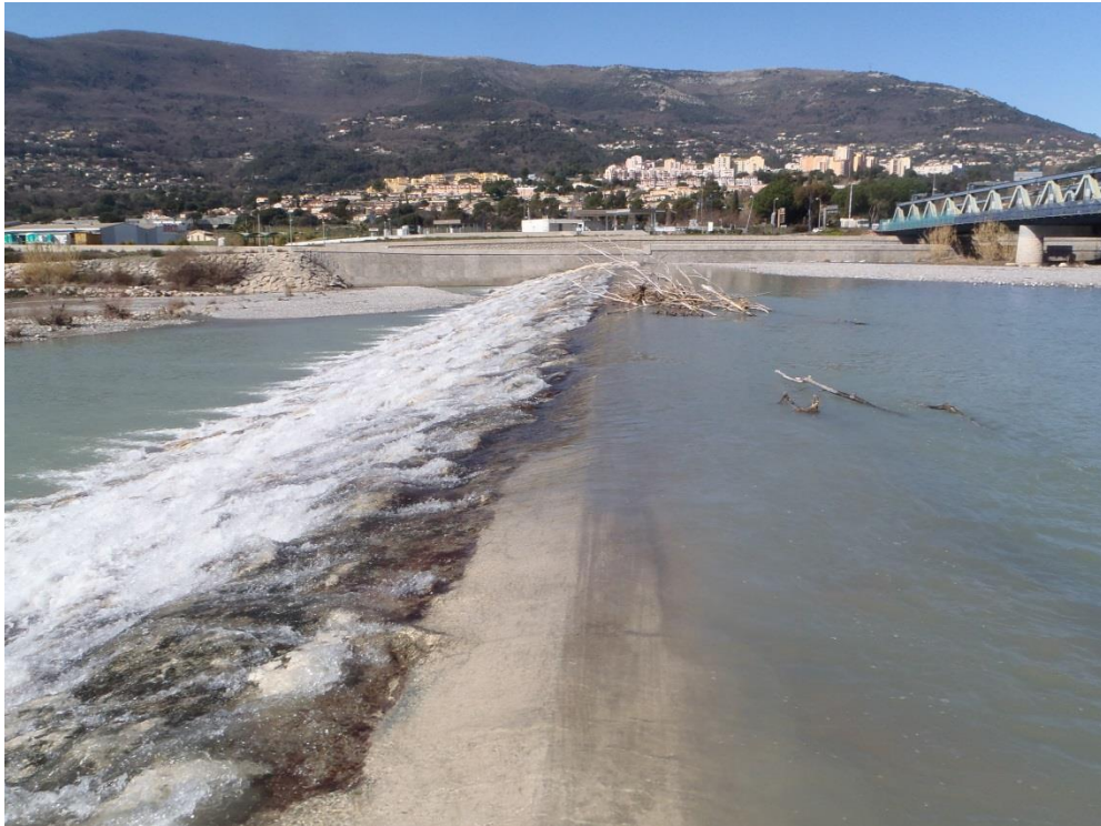
Figure 15 : Vue de la crête actuelle de l'ouvrage depuis la microcentrale (février 2016)
