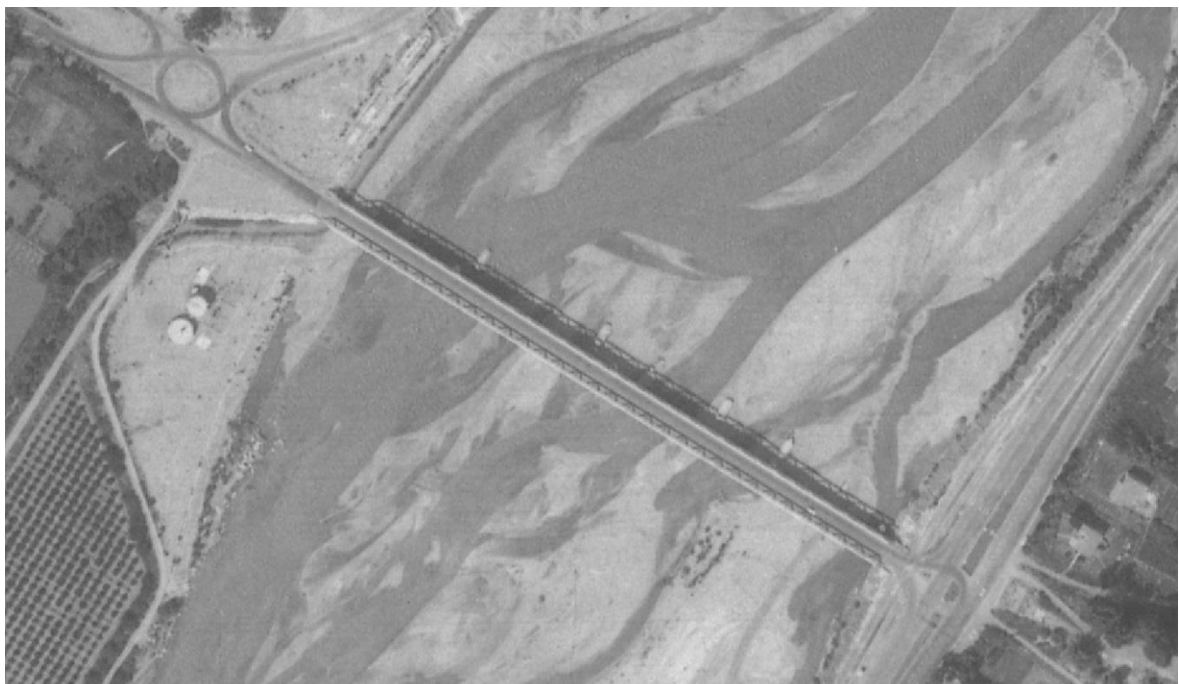
Figure 9 : Nouveau pont de la Manda en 1969 (source : IGN)
