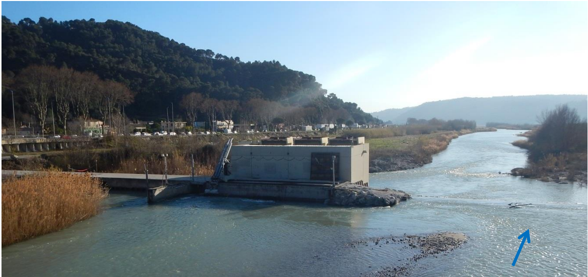
Figure 16 : Microcentrale du seuil 7 et sa voie d'accès vue de l'amont (février 2016)
