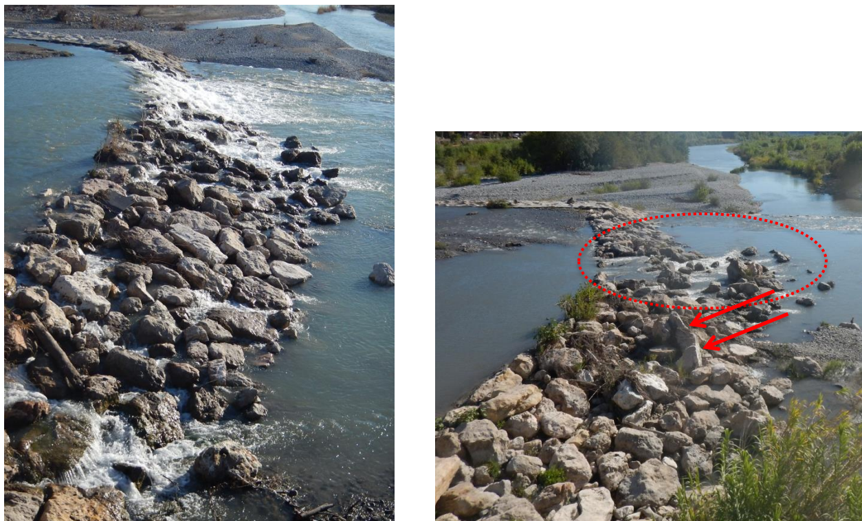
Figure 32 : Partie aval du seuil provisoire en septembre 2015 (à gauche) et en septembre 2017 (à droite)
