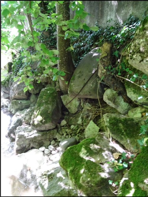
Photographie 20 (gauche) : enrochements déstructurés et revégétalisation / Photographie 21 (droite) : affouillement base enrochements bétonnés pk715 à 735
