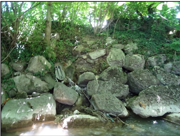
Photographie 11 (gauche) : blocs déstructurés et affouillés pk450 / Photographie 12 (droite) : blocs déchaussés pk 425
