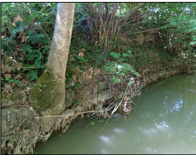
Photographie 34 (gauche) : gabions en base de berges affouillées / photographie 35 : enrochements dégradés par la végétation et indice de basculement
