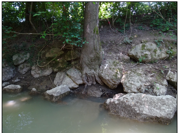
Photographie 3 (gauche) : enrochements déstructurés pk 160 / Photographie 4 (droite) : enrochements déstructurés, déchaussement de blocs et dégradation suite à la colonisation d'arbres pk50
