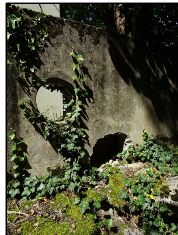
Photographies 22 et 23 : fissures et trouées au sein du muret béton
