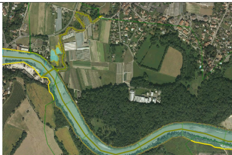
73. Premiers débordements du Foron.
