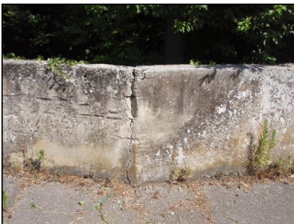
Photographies 22 et 23 : fissures et trouées au sein du muret béton
