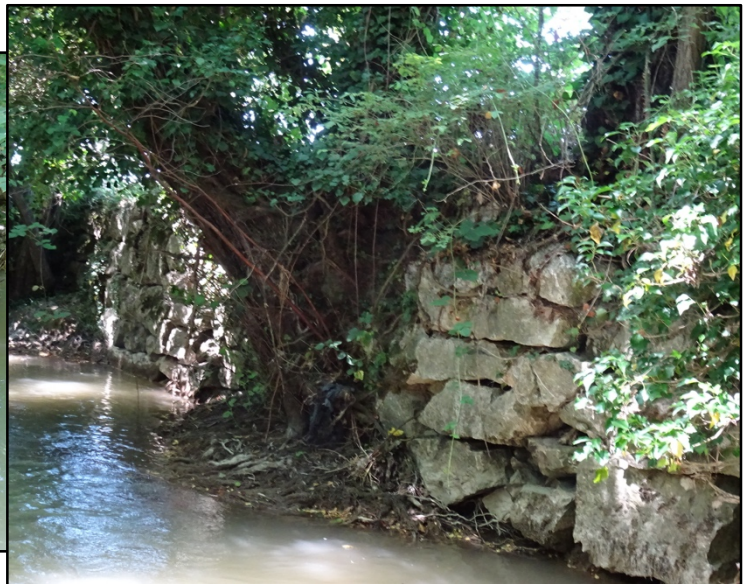
Photographie 34 (gauche) : gabions en base de berges affouillées / photographie 35 : enrochements dégradés par la végétation et indice de basculement
