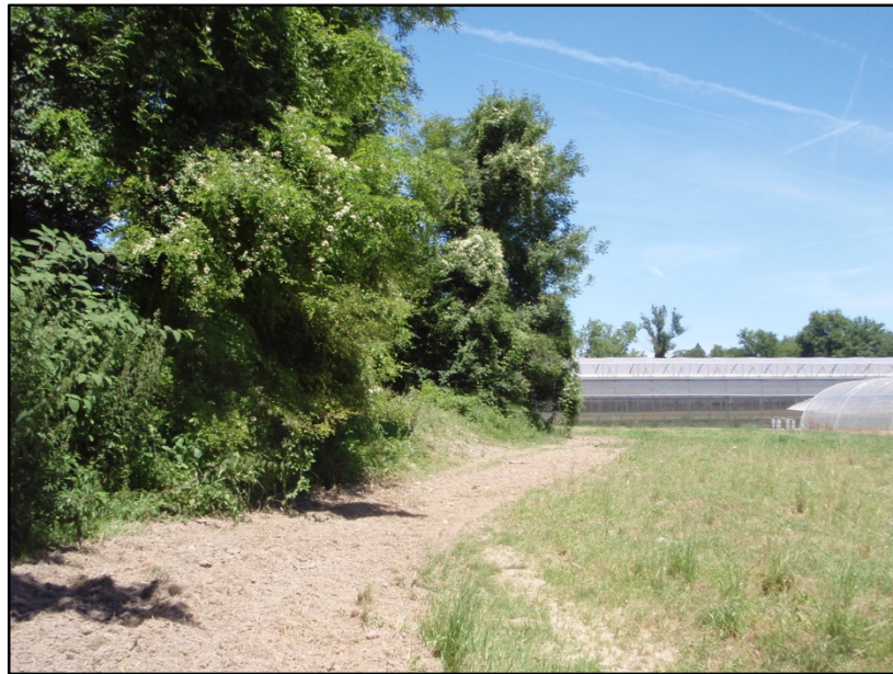
Photographie 5 : digue et talus côté terre pk110 à 150
