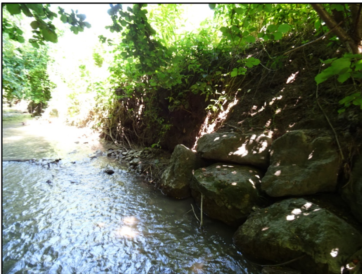
Photographie 3 (gauche) : enrochements déstructurés pk 160 / Photographie 4 (droite) : enrochements déstructurés, déchaussement de blocs et dégradation suite à la colonisation d'arbres pk50
