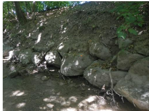
Photo 5 : Abris en berge créés par les interstices entre enrochements en rive gauche
