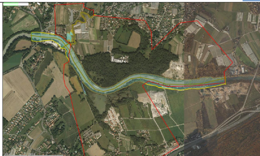
9. Premiers débordements du Foron.
