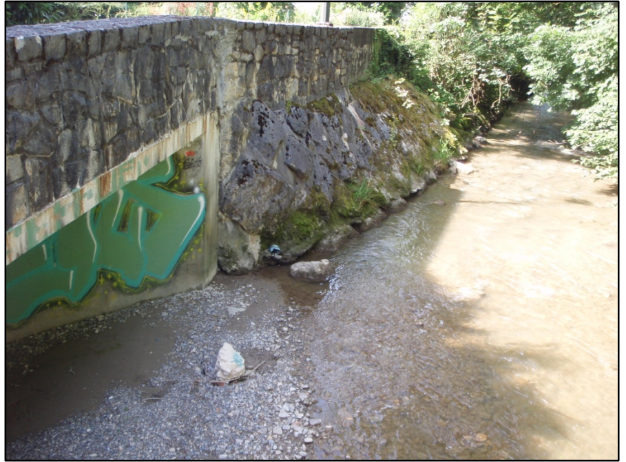
Photographie 20 (gauche) : enrochements déstructurés et revégétalisation / Photographie 21 (droite) : affouillement base enrochements bétonnés pk715 à 735
