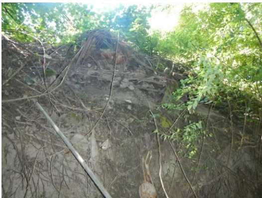
Photo 10 : amoncellement de débris de tout genre en haut de berge rive droite
