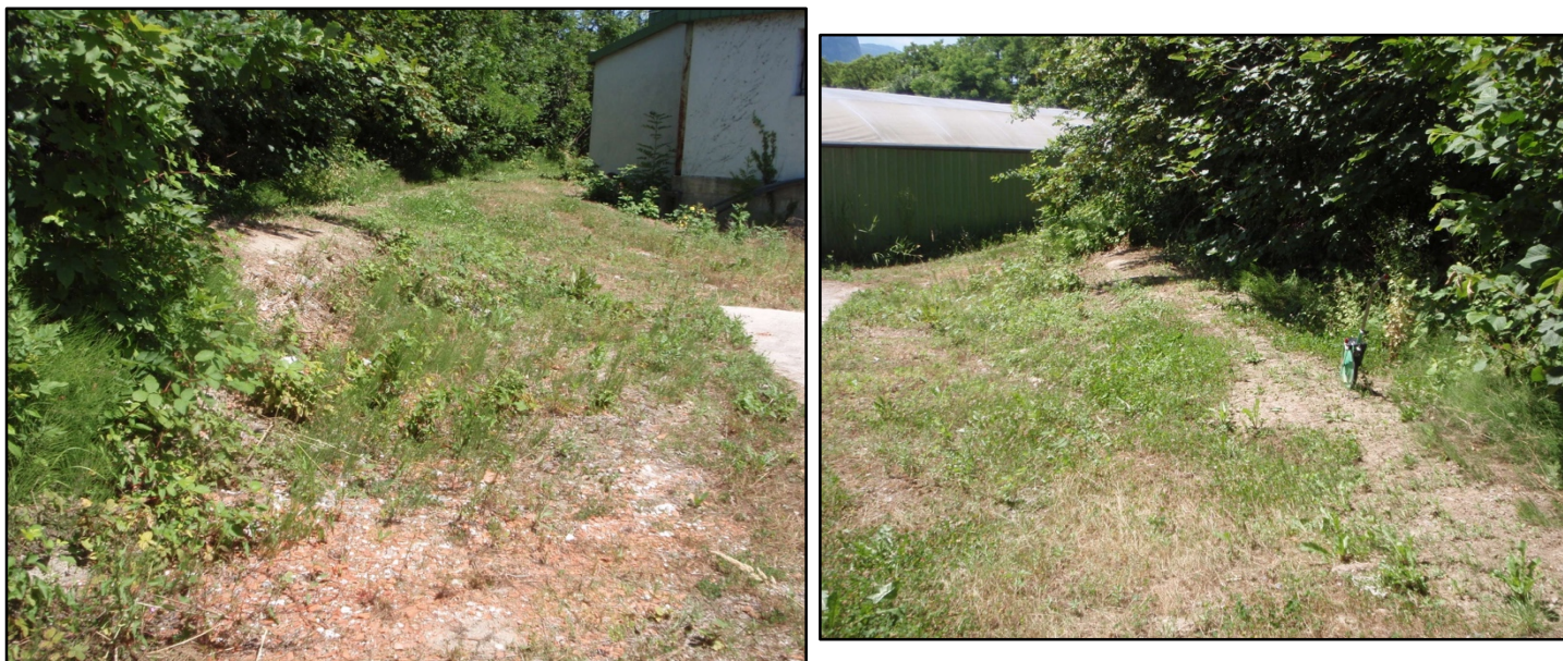
Photographies 9 et 10 : digue visible entre le pk 290 et 320
