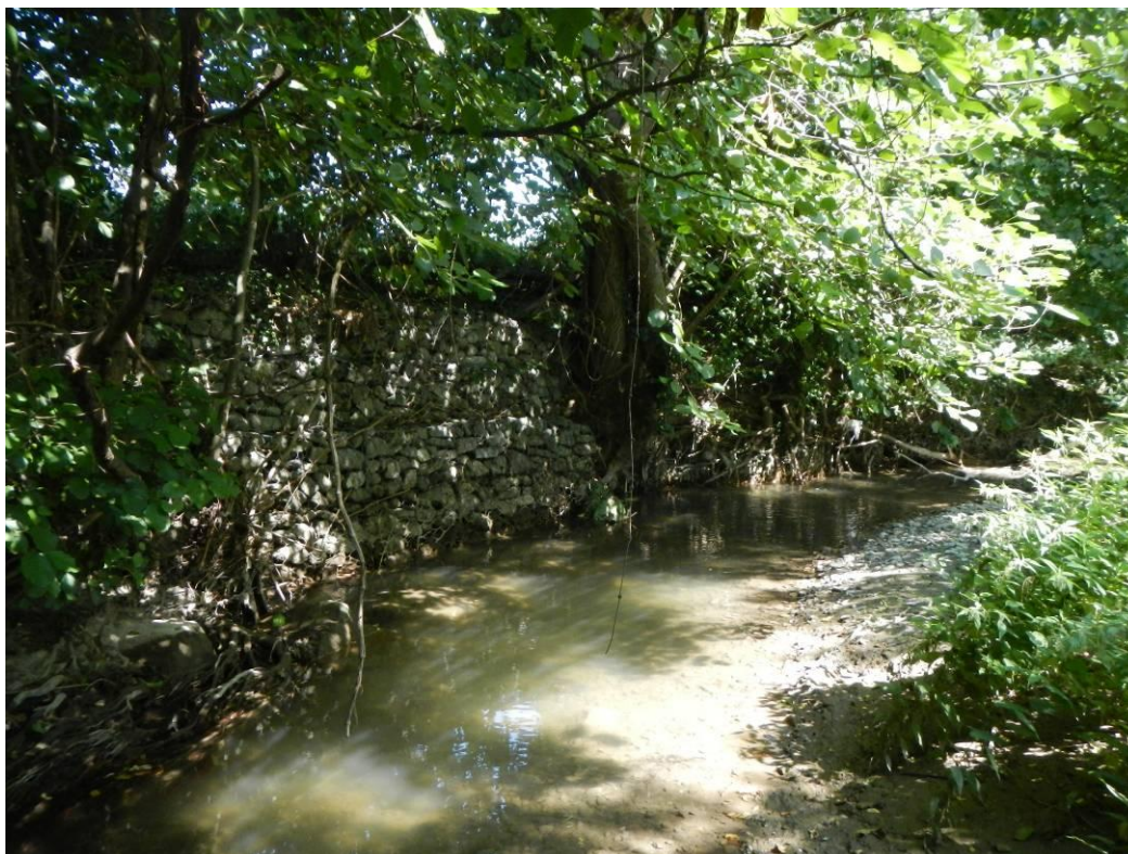
Figure 29 : Gabions en rive droite et ripisylve "ouverte" en RG (HYDRETTUES, 31/08/2016)
