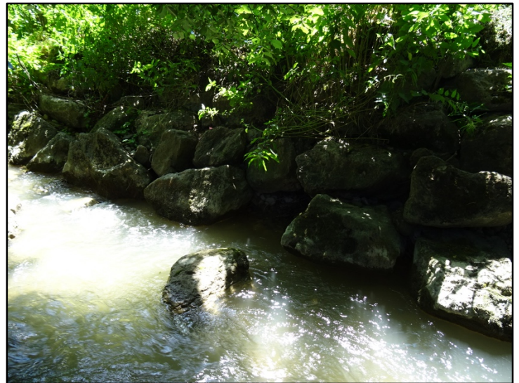
Photographie 11 (gauche) : blocs déstructurés et affouillés pk450 / Photographie 12 (droite) : blocs déchaussés pk 425
