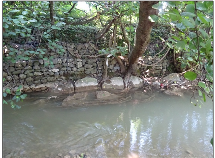
Photographies 28 et 29 : ouvrages de soutènements fortement dégradés
