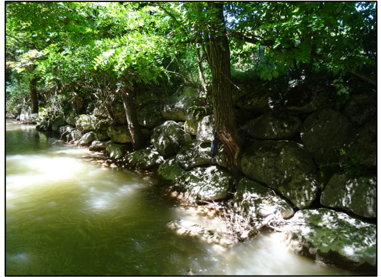
Photographie 36 (gauche) : talus de faible hauteur érodé en pied / photographie 37 (droite) : enrochements libres légèrement désorganisés et présence d'arbres au sein de l'ouvrage
