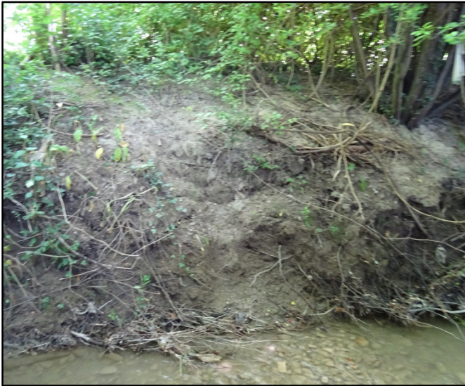
Photographie 1 (gauche) : ravinement pk 185 – 195 / Photographie 2 (droite) : érosion du pied de talus côté rivière
