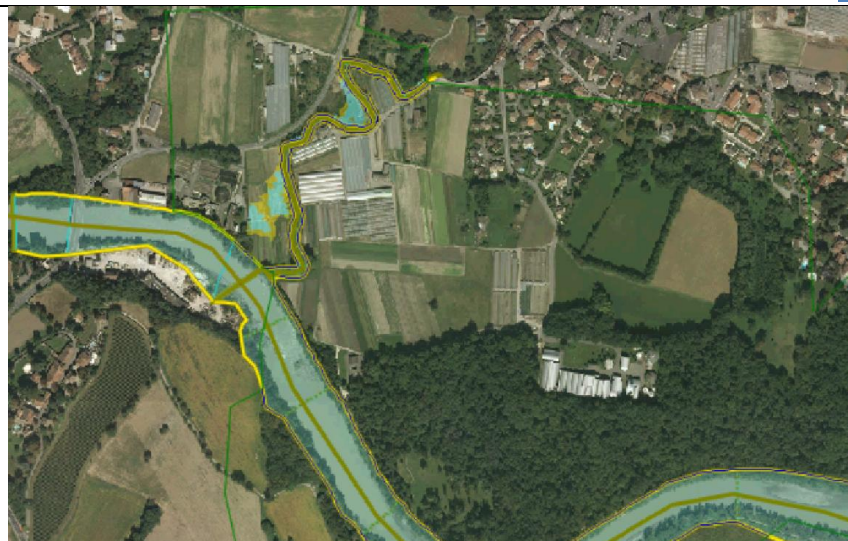
61. Premiers débordements du Foron.
