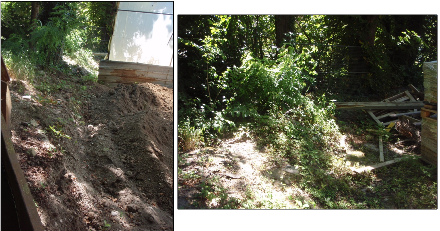
Photographies 32 et 33 : digues remaniées et merlon en terre faisant office de digue
