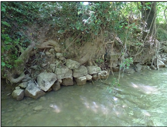
Photographies 25 et 26 : sous-cavage des arbres et confortement sommaire observés
