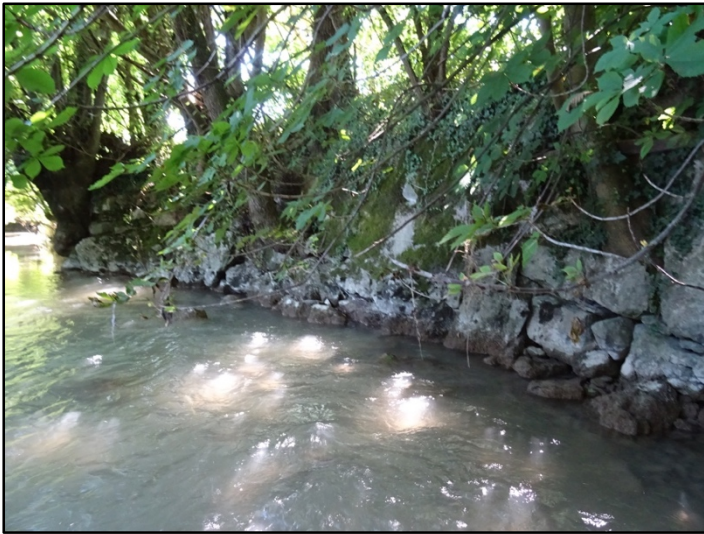
Photographies 28 et 29 : ouvrages de soutènements fortement dégradés
