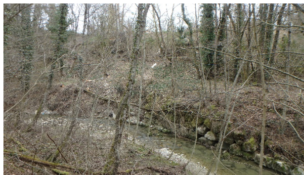
Protection de berge encore bien visible
