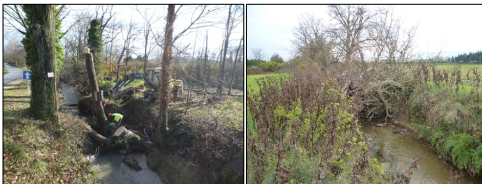
Façonnage d'un tronc obstruant le lit / problématique d'engraissement d'un embâcle en amont de zones urbaines
