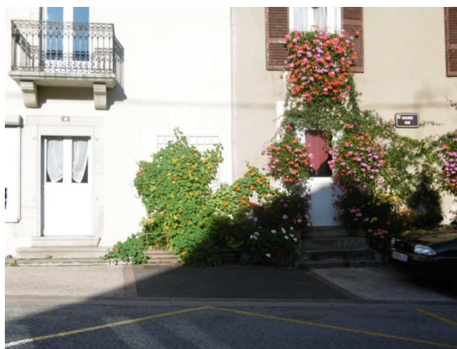
Exemple de végétalisation de pieds murs chez des particuliers
