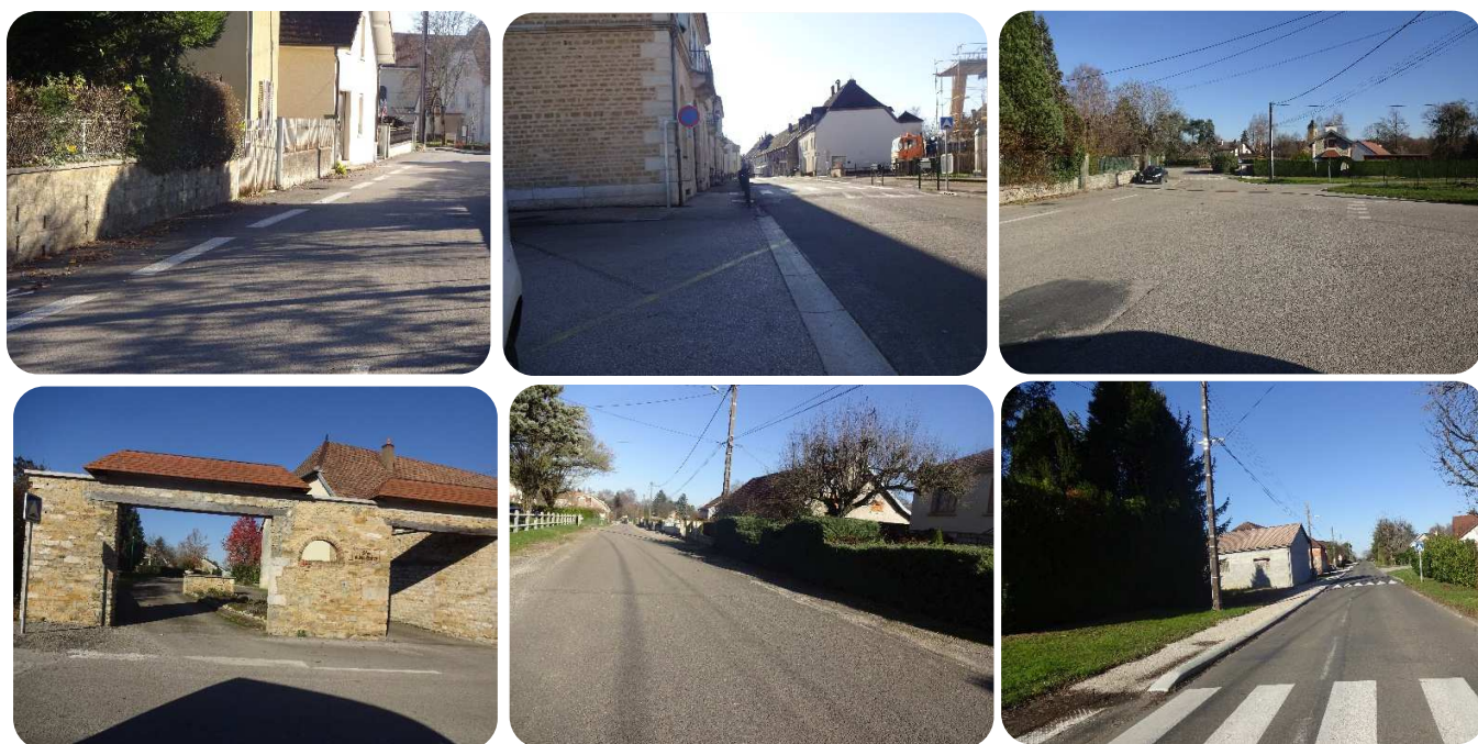
Exemples de rues de Mont-sous-Vaudrey qui témoignent d'un bon état de la voirie sur les axes principaux
