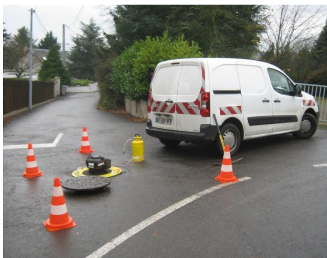
1 - Injection de fumée dans le réseau d'eaux usées
