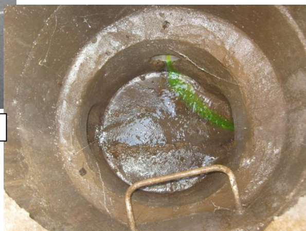
3 - Validation de la connexion hydraulique à l'aide de colorant
