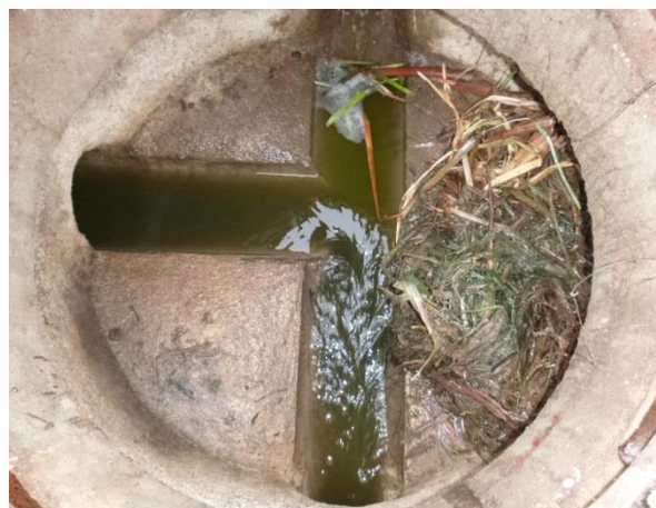
Nid de ragondin retiré de la cunette du regard situé entre les deux bassins
