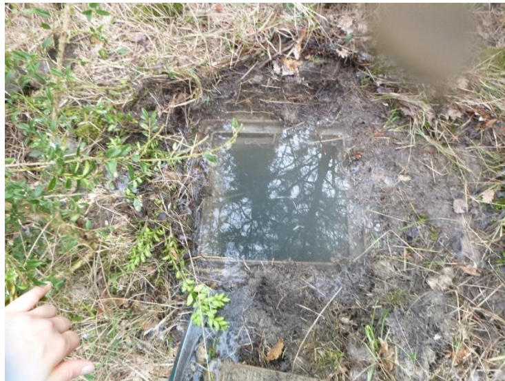
Ancien réservoir en charge
