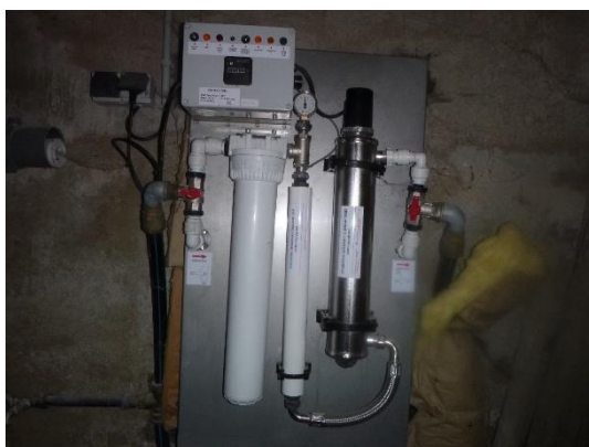
Traitement UV Savel Bas- Vue intérieure
