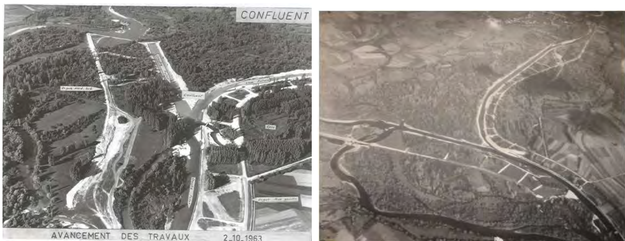
Fig. 1. Figure 1 : Travaux d'aménagement de la confluence - Vue des travaux en cours de réalisation (à gauche) et Travaux achevés en novembre 1964 (à droite) – Source : DDT du Jura
