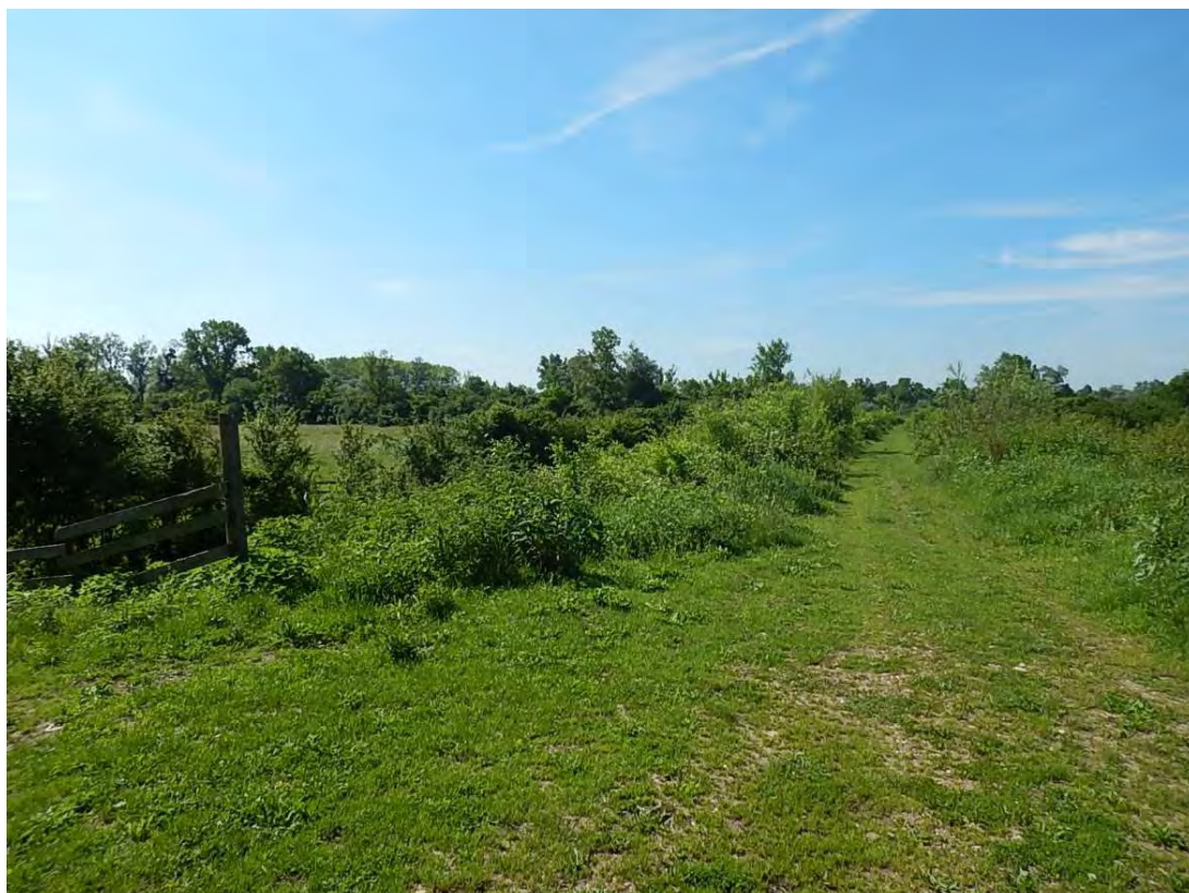
Fig. 106. Vue sur la digue de la RNN
