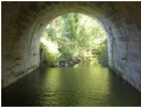
Vue de l'ouvrage depuis l'amont
