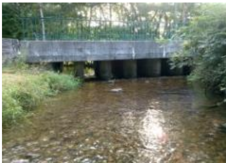
Vue de l'ouvrage depuis l'amont
