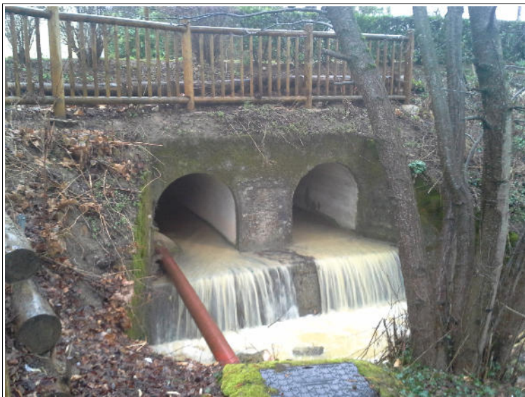
Ouvrage hydraulique n°5
