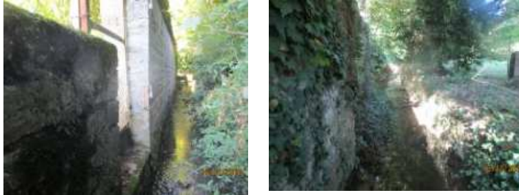
Figure 32 : Vue des berges de l'actuel bras affluent de la Petite Mouge de l'aval vers l'amont
