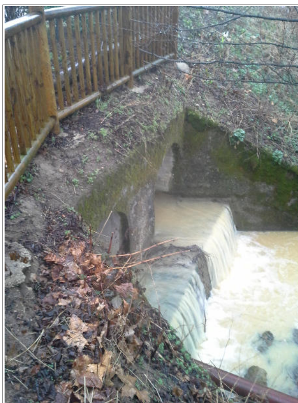
Phot de l'aval de l'ouvrage n°5
