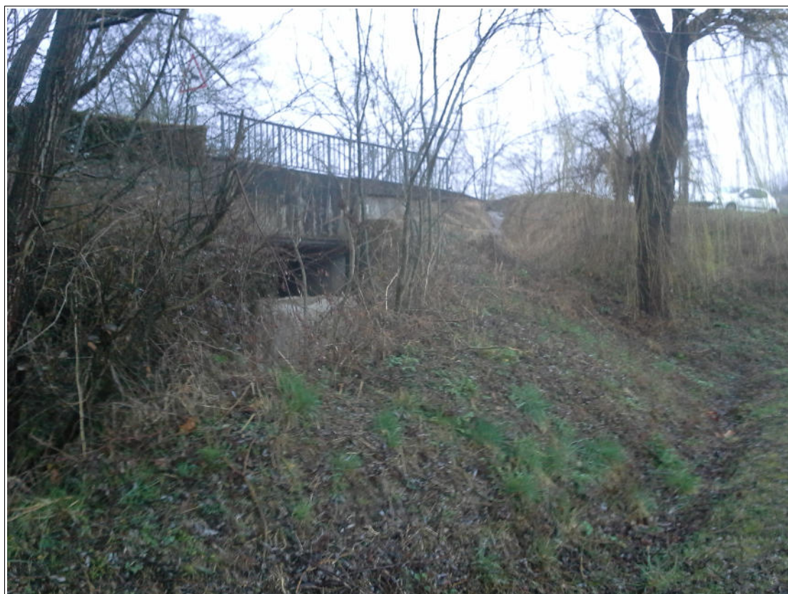
Photo de l'aval de l'ouvrage n°4
