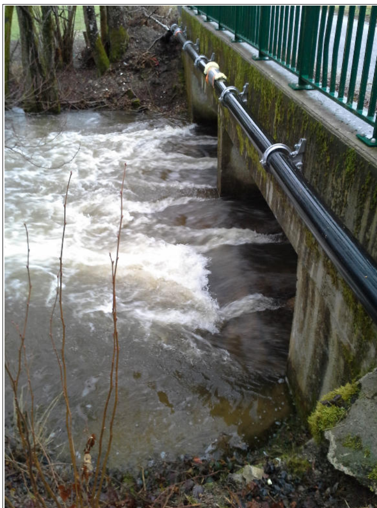
Photo de l'aval
