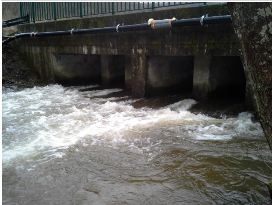
DIAGNOSTIC D'OUVRAGE HYDRAULIQUE SOUS LA RD179 SAINT LÉGER SOUS BEUVRAY (71)
