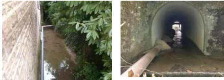
Figure 33 : Vue des réseaux concernés
