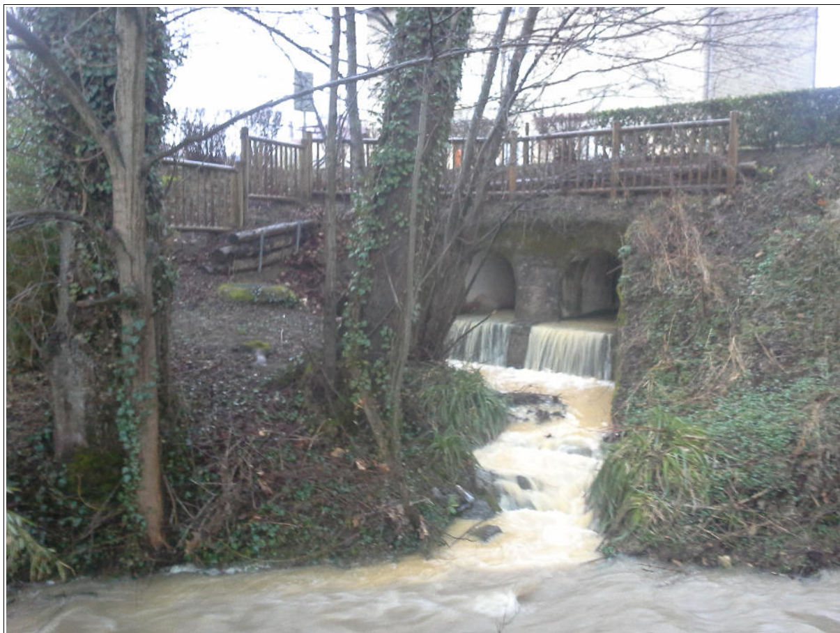
Photo de l'aval de l'ouvrage n°5
