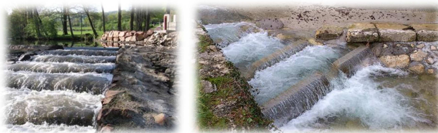
Figure 37 : Exemples de prébarrages
