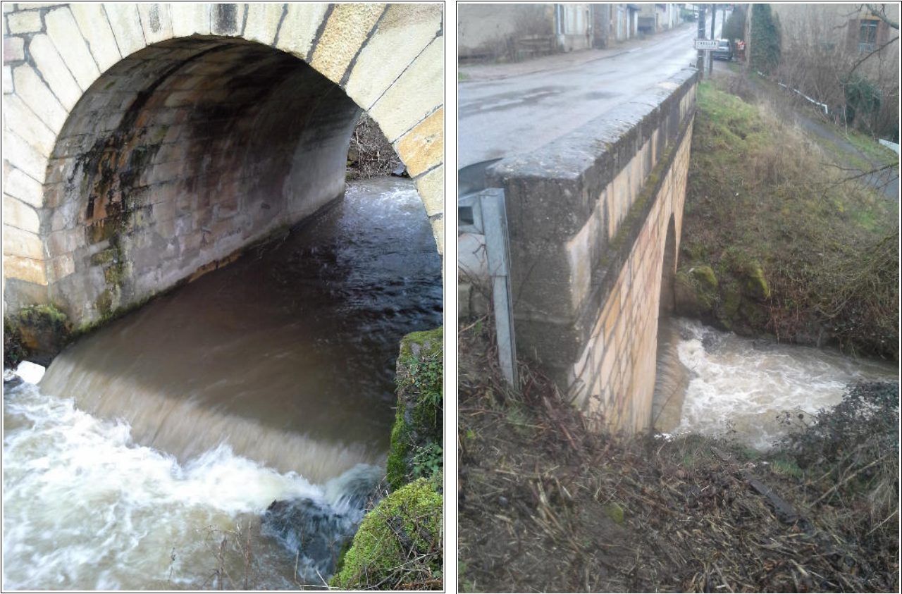
Aval du pont
