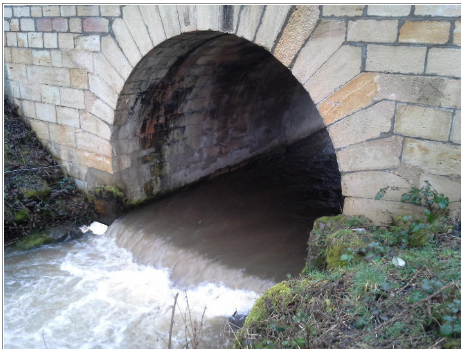
DIAGNOSTIC D'OUVRAGE HYDRAULIQUE SOUS LA RD81 COUBLANC (71)
