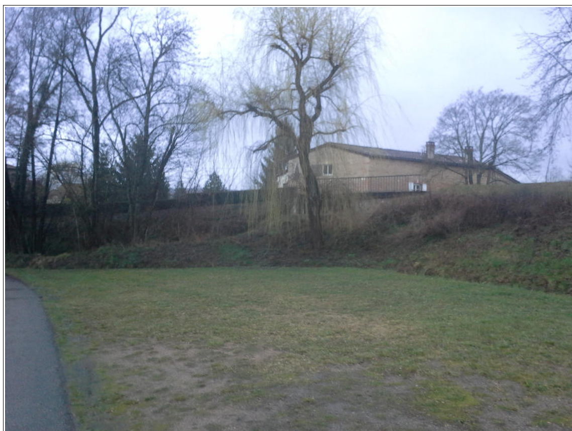
Photo éloignée de l'aval de l'ouvrage n°4
