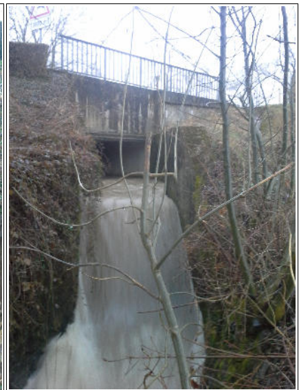
Ouvrage hydraulique n°4
