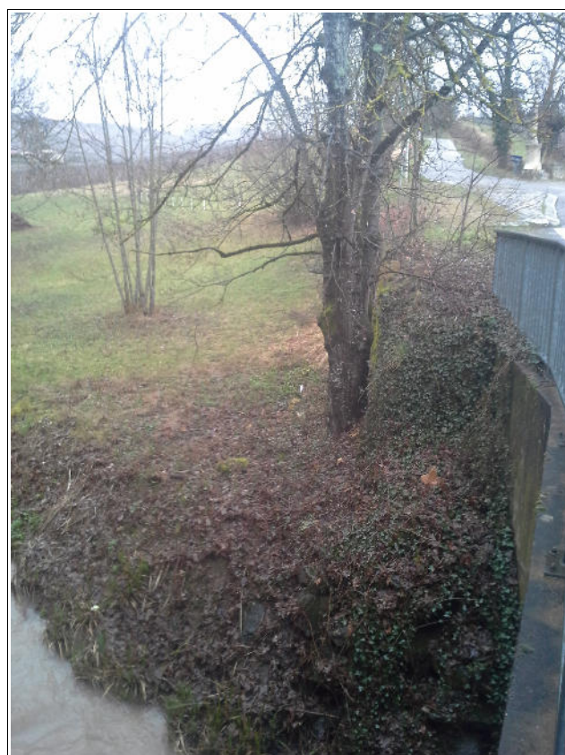
Photo de l'amont de l'ouvrage
