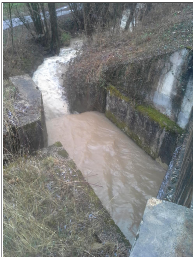
Photo de l'aval de l'ouvrage
