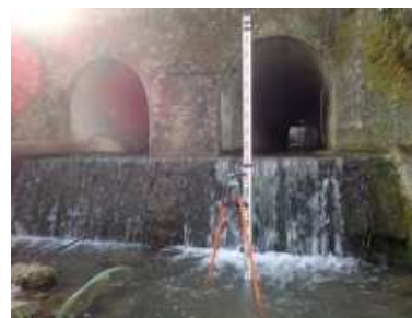
Vue de l'ouvrage en moyennes eaux (03/17)
