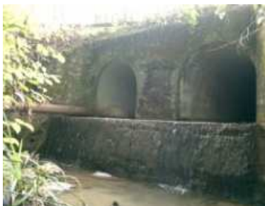
Vue de l'ouvrage en basses eaux (08/16)
