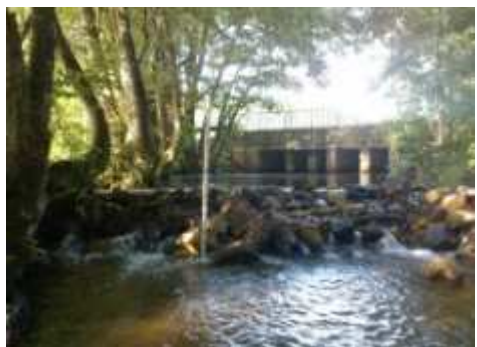
Vue de l'ouvrage et du seuil depuis l'aval
