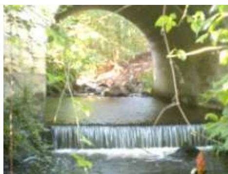
Vue de l'ouvrage depuis l'aval
