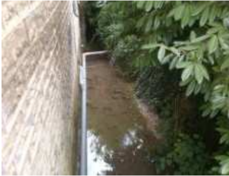
L'affluent en amont de l'ouvrage
