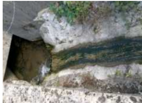
La rampe béton en amont de l'ouvrage
