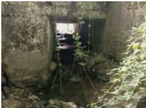
Vue de l'ouvrage depuis l'aval
