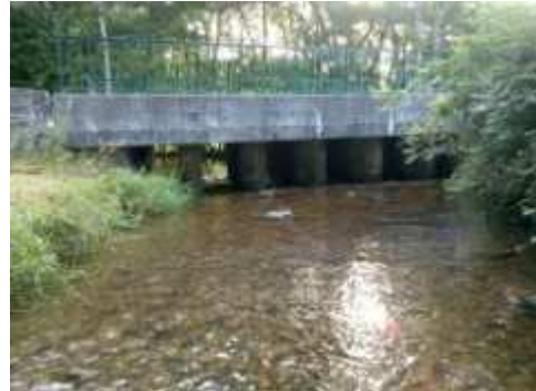
Vue de l'ouvrage depuis l'amont
