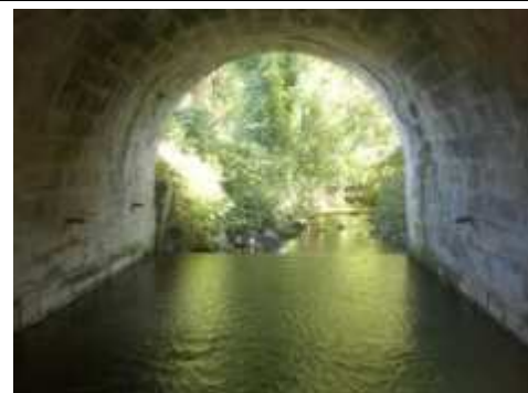
Vue de l'ouvrage depuis l'amont
