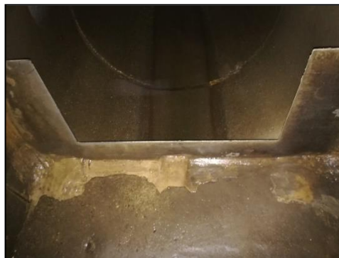
Figure 9 : Exemple de lame déversante
