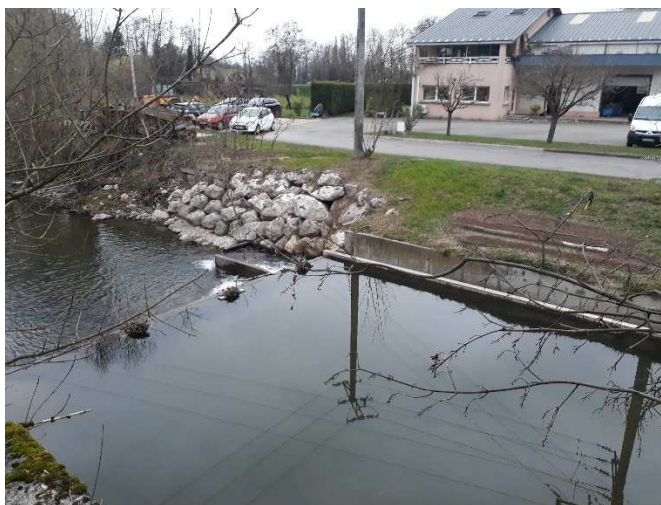
Figure 10 : Ouvrage de contrôle au niveau du site de prélèvement pour le remplissage de la retenue collinaire d'Ogny : le débit réservé correspond au débit circulant dans la passe à poissons visible à l'arrière-plan
