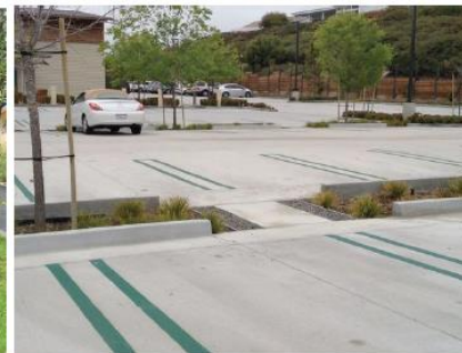
Parking avec noue végétalisée d'infiltration des EP
