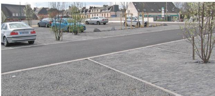
Parking en dalles alvéolées gravillonnées à Allouestre (dépt : 56)
