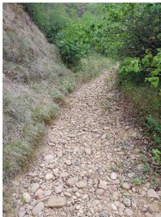
Chalon en milieu de bassin versant
