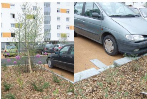
Parking en stabilisé avec noue d'infiltration, Mâcon (dépt : 71) Noue végétalisée
