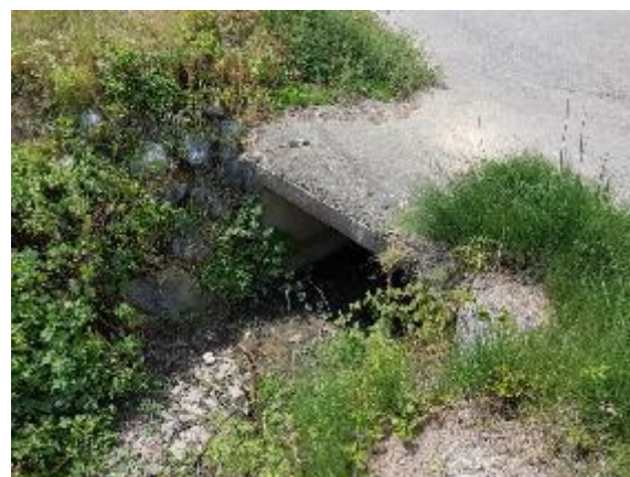
Ouvrage de franchissement du Chemin des Fabriques
