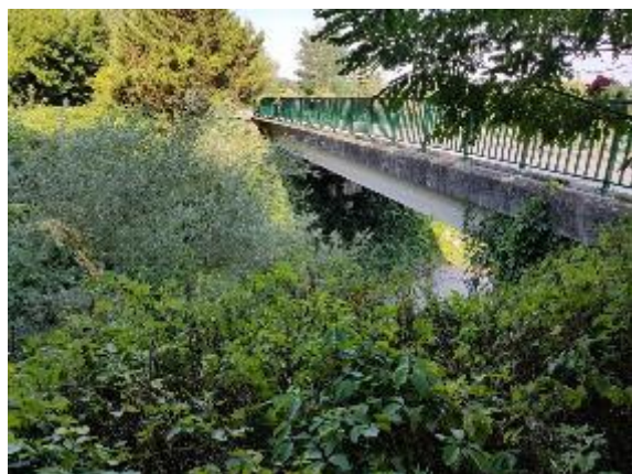
L'Herbasse au droit du pont de la D114
