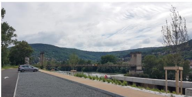
Parking en concassé, Rochetaillée-sur-Saône (dépt : Rhône)
