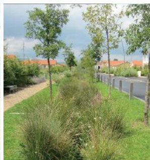
Parking en stabilisé avec noue d'infiltration, Mâcon (dépt : 71) Noue végétalisée
