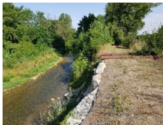
Poste de relevage en amont du centre-ville - lotissement Clerval (2/2)
