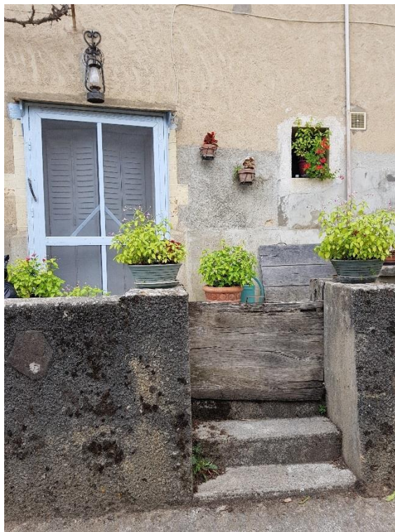
Figure 11 : Système de batardeaux mis en place par les riverains de la rue du Chalon (source : Prolog Ingénierie)
