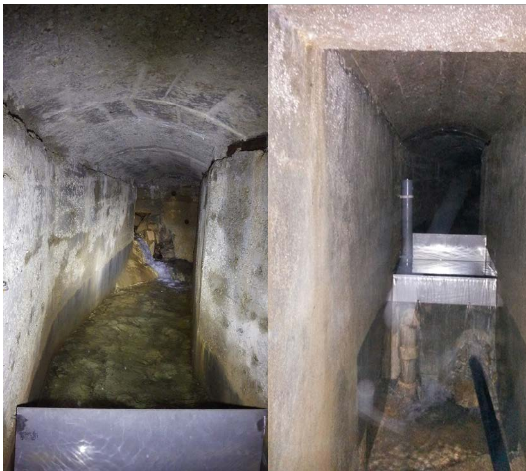
Figure 72. Vues de la chambre de captage de la source Moulin (10882X0203/MOULIN) et du seuil mis en place.
