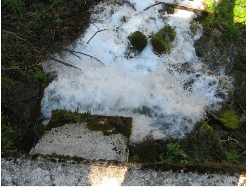
Figure 73. Vue du trop-plein de la source du Moulin à l'extérieur de la chambre de captage
