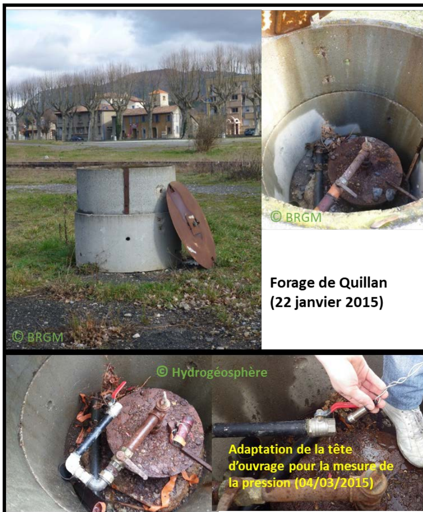
Figure 106. Vue du forage de Quillan et de la tête de forage.
