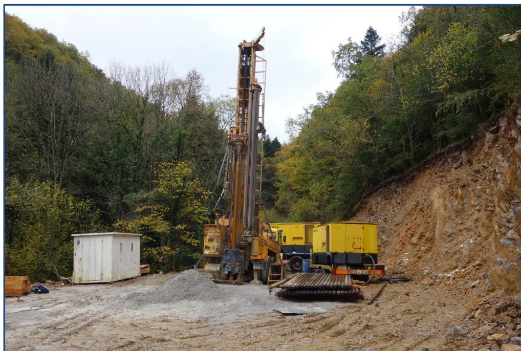
Illustration 3 : Vue du chantier depuis la plateforme du forage BLAU (Novembre 2017)
