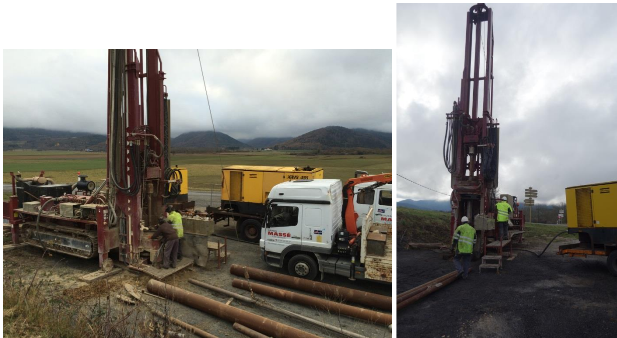
Illustration 3 : Vue du chantier depuis la plateforme du forage ESPEZEL (Janvier 2017)
