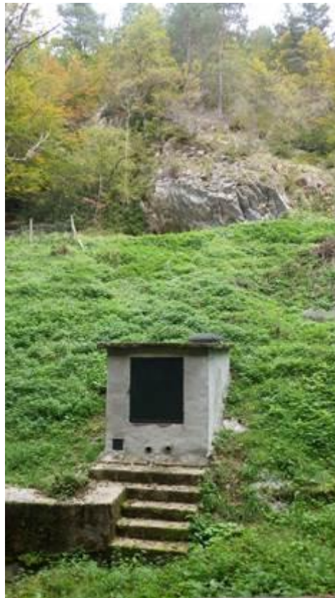
Illustration 128 : Vue du captage de la source Argeliers
