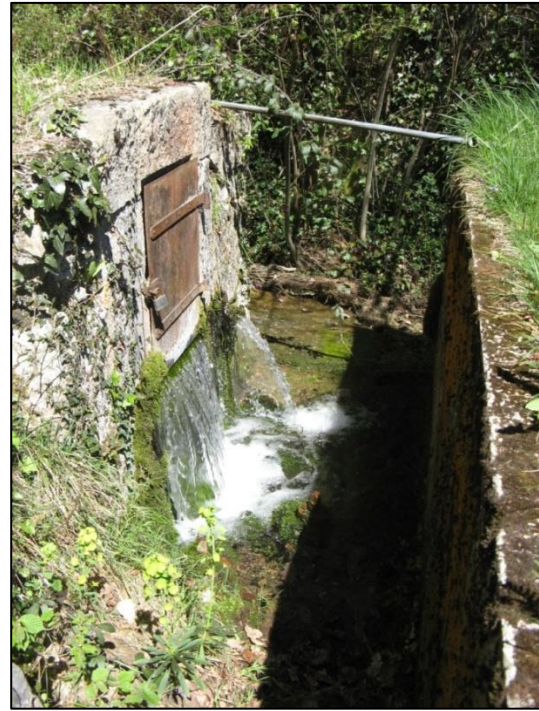
Illustration 108 : Photographies de la sortie temporaire de la source de Belfort-sur-Rébenty, et du trop-plein du captage.
