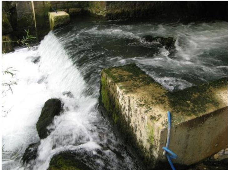
Vue du seuil sous le pont
